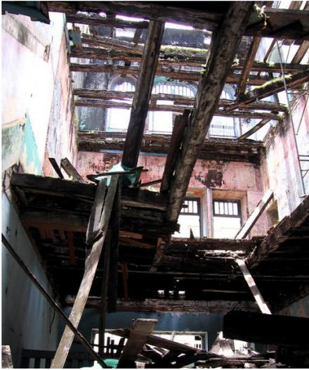
**Figura 16.** Foto do interior do Edifício Chanteclair em estado de deterioração, 2008. Fonte: <https://www.flickr.com/photos/ermo/3163671256>. Foto: Acervo Pedro Valadares.
