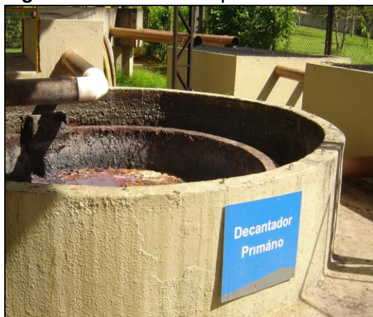
Figura 3C: Decantador primário
