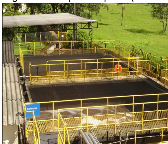
Figura 9C: Tanque de equalização
