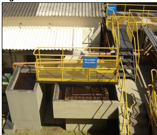
Figura 11C: Decantador secundário
