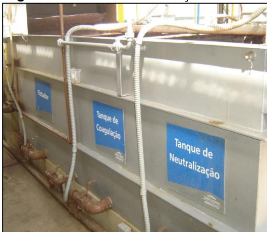
Figura 6C: Sistema de flotação
