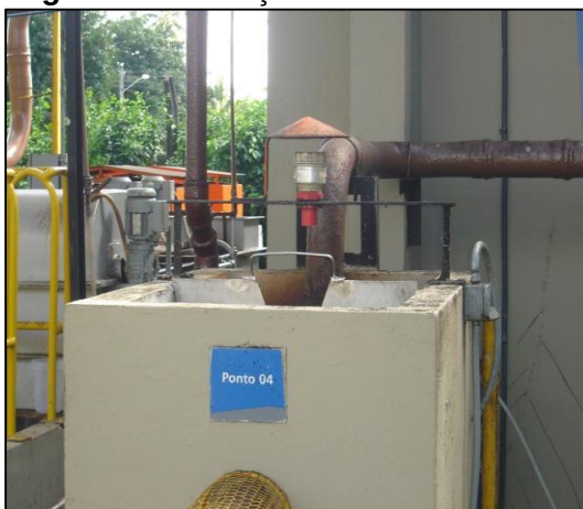
Figura 12C: Estação elevatória III
