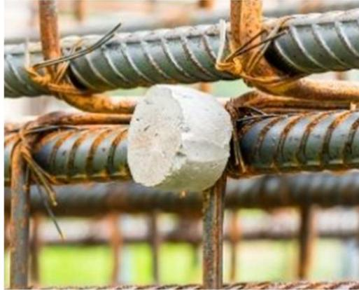
Figura 21 – Espaçador de concreto fixado na armadura.
