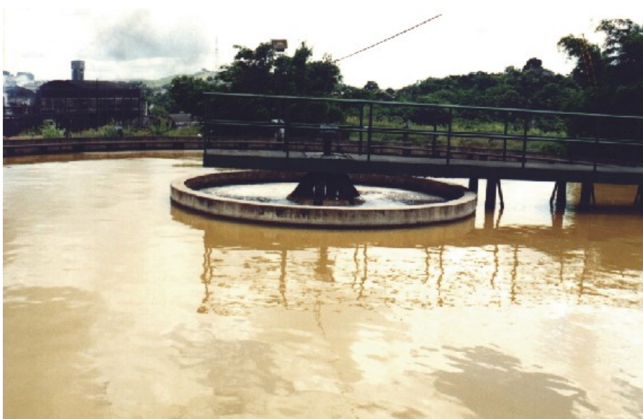
Foto 8 – Sistema de tratamento de indústria localizada em Jaboaão dos Guararapes.
