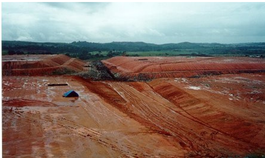
Foto 2 –Aterro controlado da Muribeca.
