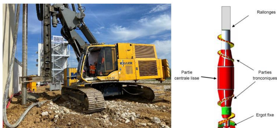
Figura 1: A esquerda, foto da execução de uma inclusão rígida. A direita, trado utilizado na execução.
