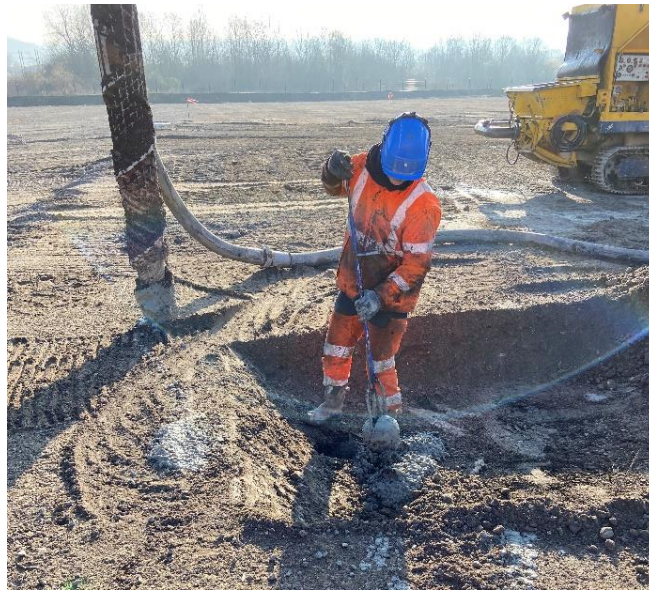
Figure 7 : Réalisation d'un arasement avec une louche en béton. Source : Archive personnel.
