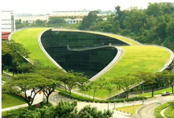
Figura 2 - Telhado verde da Universidade Tecnológica de Nanyang, Cingapura
