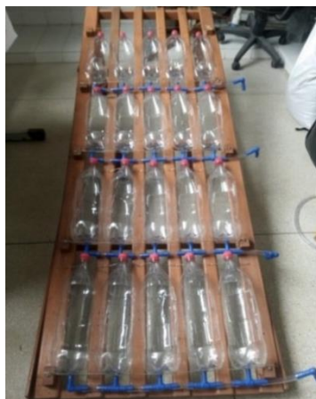
Figura 20 - Estrutura com o sistema para a cobertura ecológica finalizado
