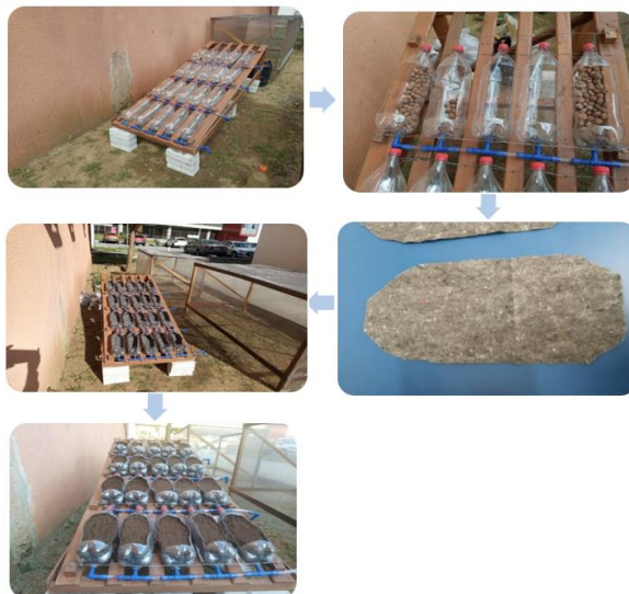
Figura 26 - Montagem do substrato
