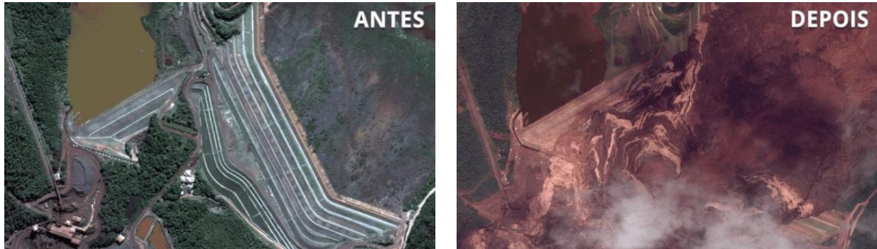
Figura 16 - Rompimento da barragem B1 em Brumadinho.
