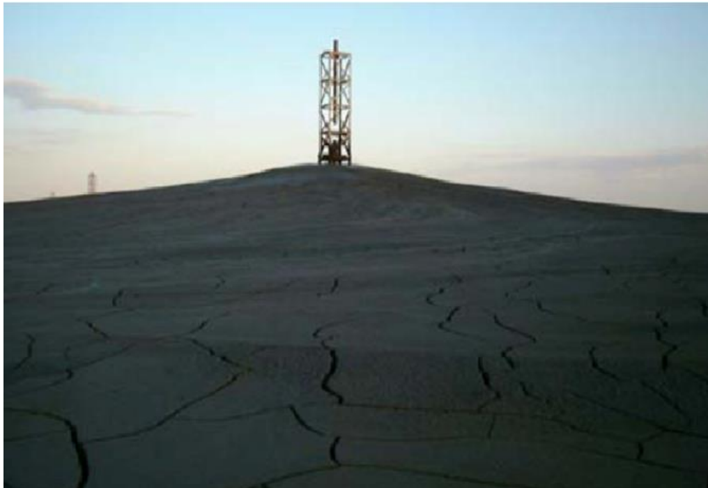
Figura 11 - Disposição de rejeitos em pilha cônica.
