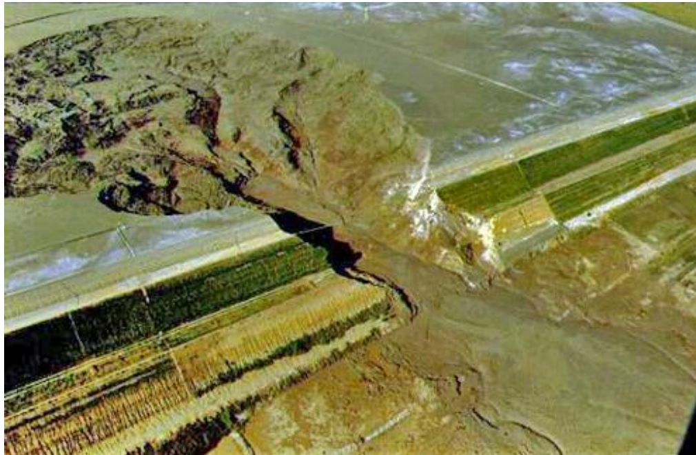
Figura 20 - Ruptura da barragem de Merriespruit – África do Sul.
