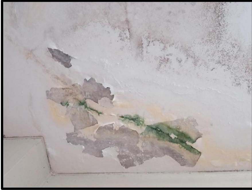
**Figura C-4** – empolamento e descascamento de pintura no teto.
