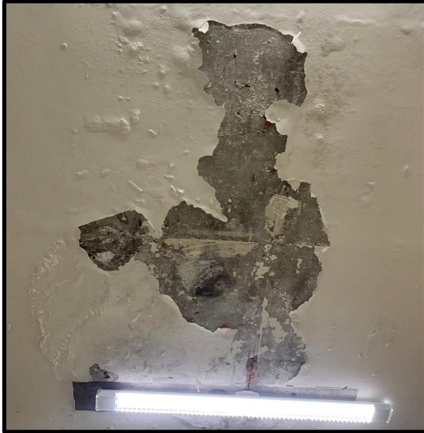
**Figura C-6** - presença de saponificação e mofo no teto.
