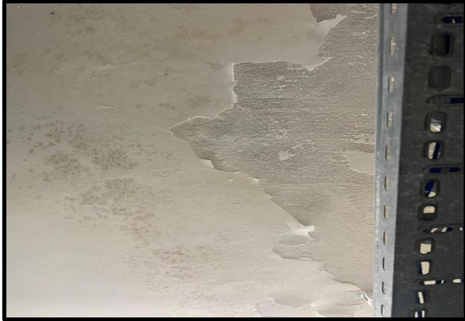
**Figura A-4** – empolamento e descascamento de pintura na parede, próximos ao rodapé.
