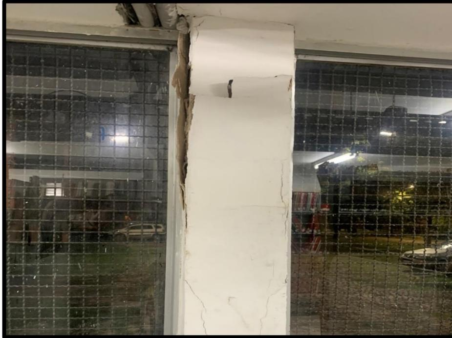
**Figura A-2** – fungo e empolamento de pintura próximos a janela e no teto.
