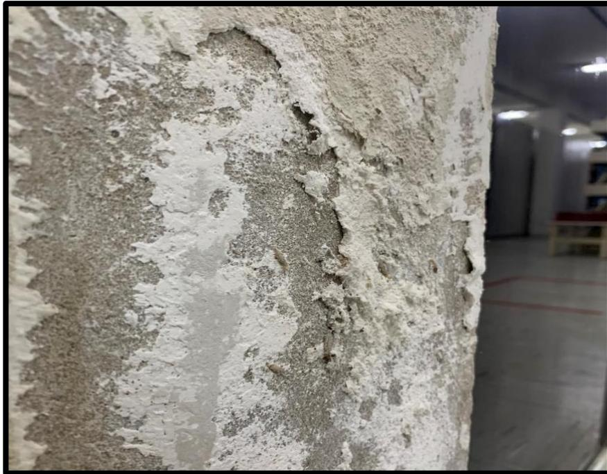
**Figura B-3**– descascamento e empolamento de pintura.
