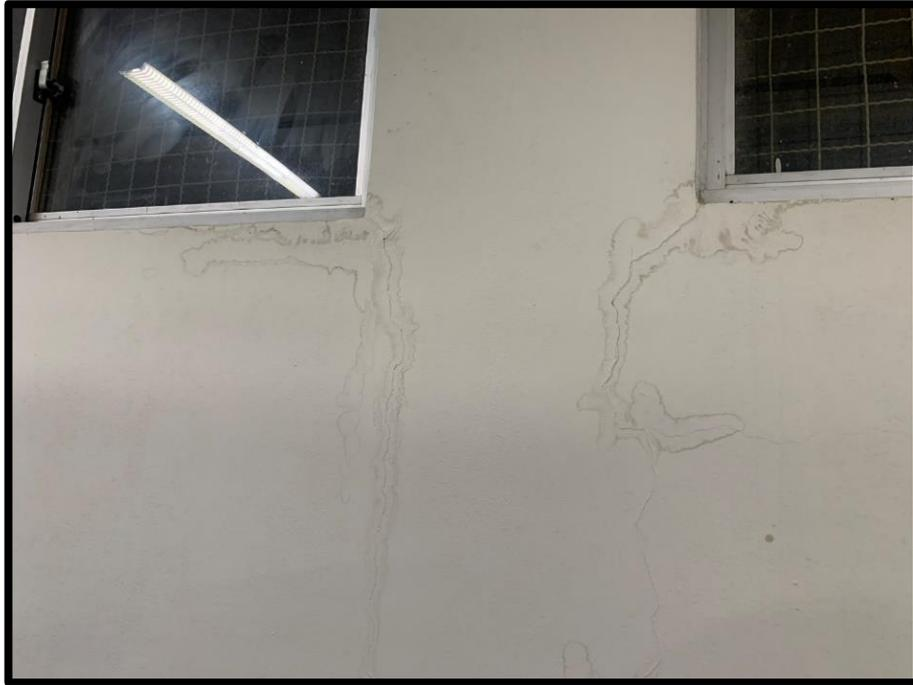
**Figura B-2**– eflorescência em parede.
