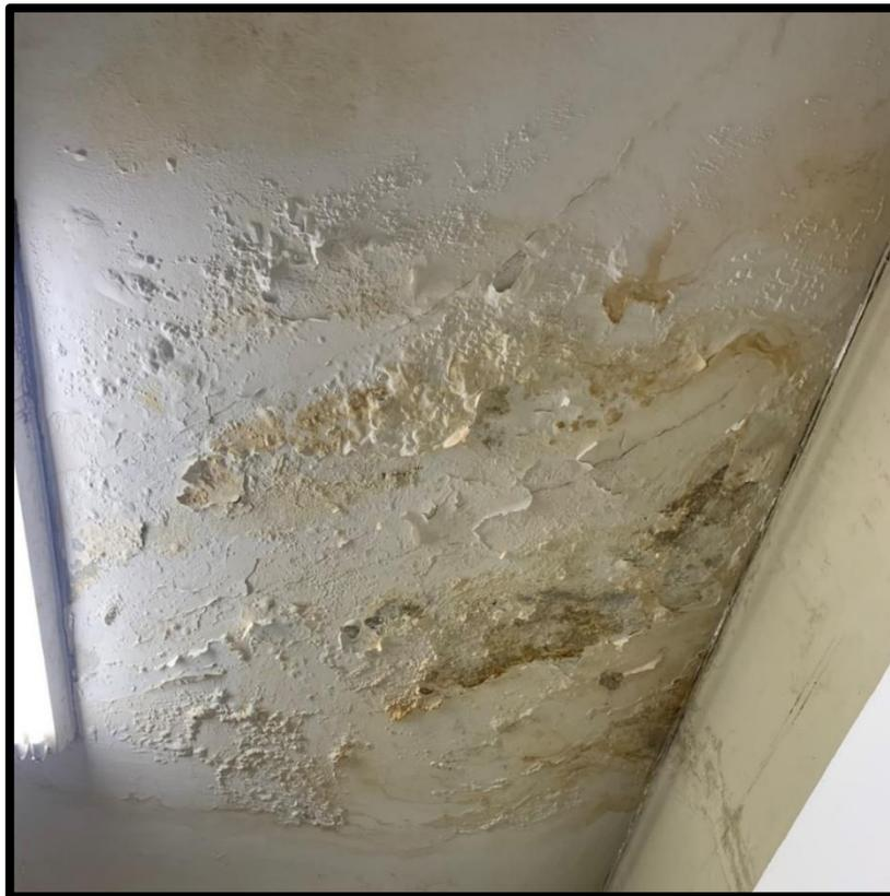
**Figura C-5** – empolamento e descascamento de pintura no teto.
