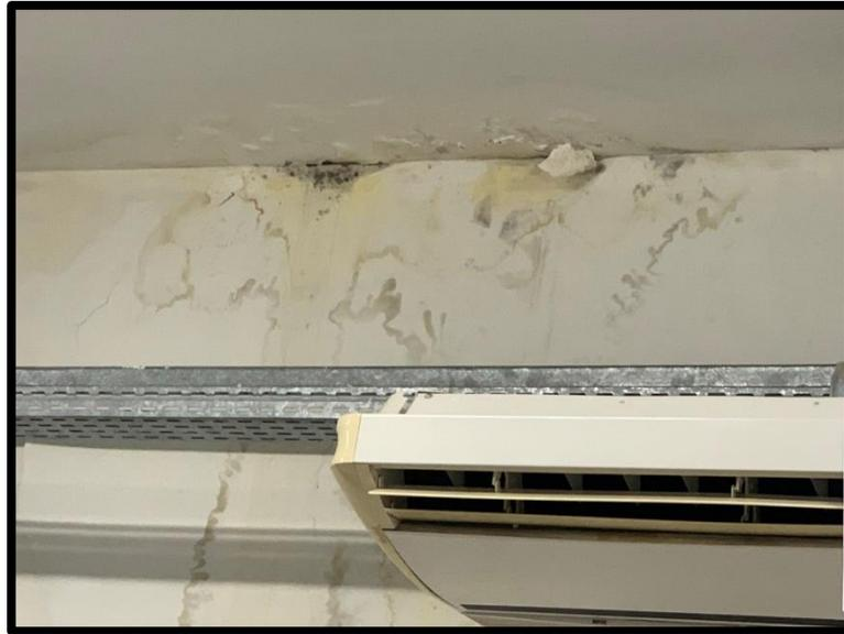
**Figura D-2** – descascamento de pintura no teto.
