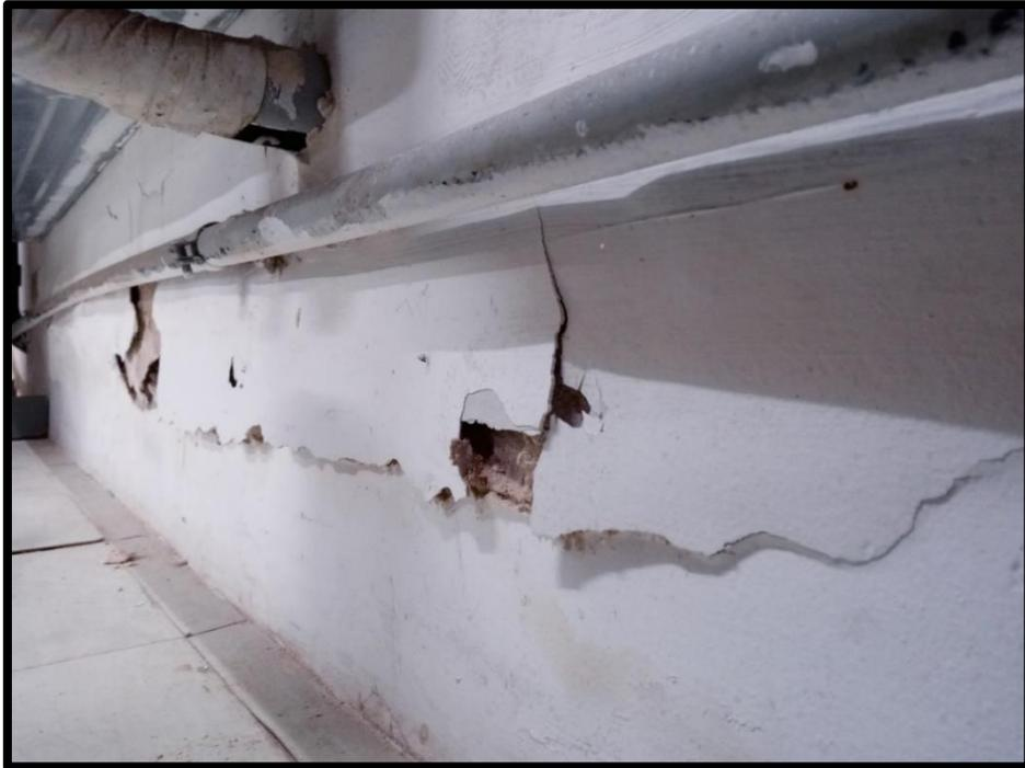
**Figura C-2** – deslocamento de revestimento cerâmico no piso.
