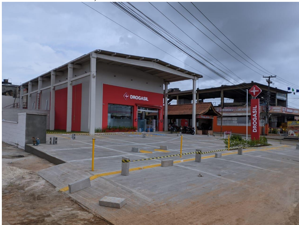
Figura 5 - Fotografia da construção de uma segunda unidade da Drogasil, Av. Henrique de Holanda, cidade de Vitória de Santo Antão/PE
