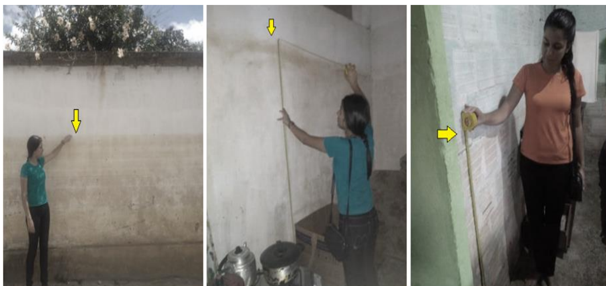
Fotografia 2 - Registros da coleta de marcas de inundação em Jaqueira - PE.
