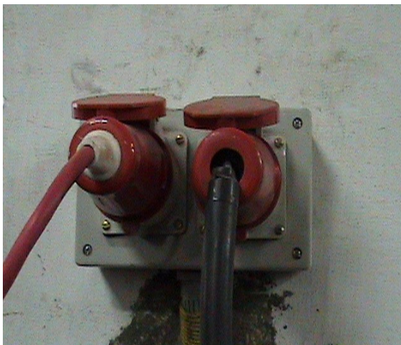
Figura 7.15-Ligação das máquinas de solda após a reengenharia
