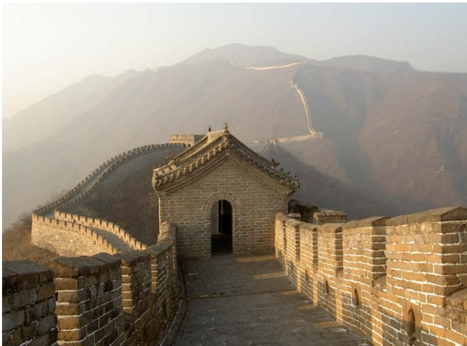
Figura 1.3 - Muralha da China
