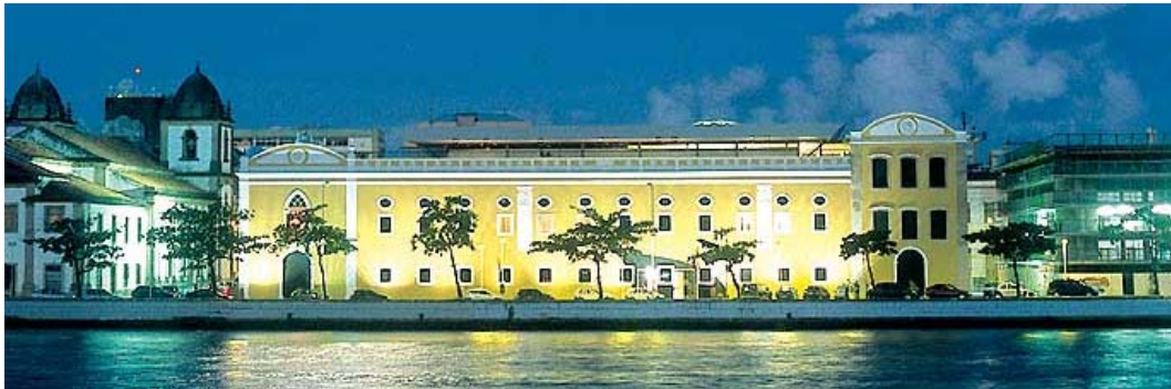
Figura 1.4 - Paço Alfândega (Fachada)
