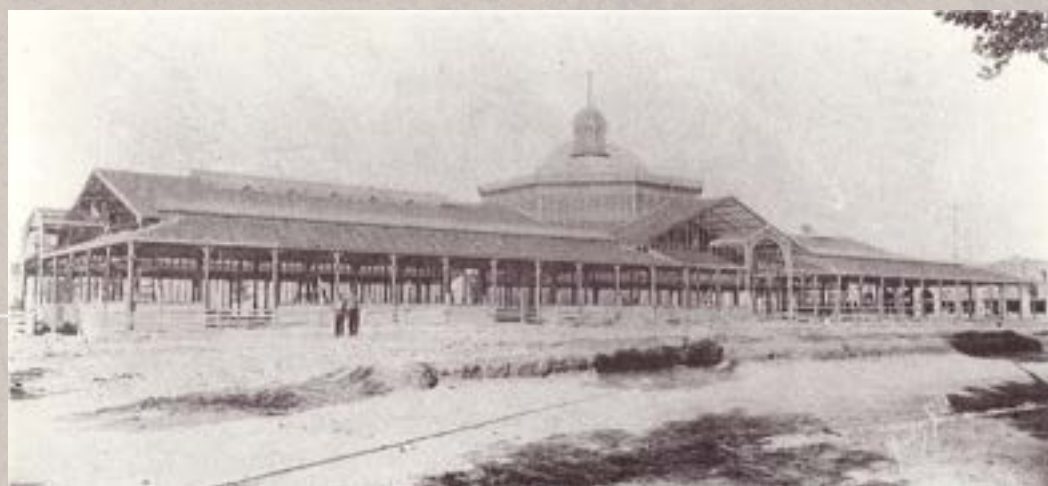
Figura 17 - Construção do mercado
