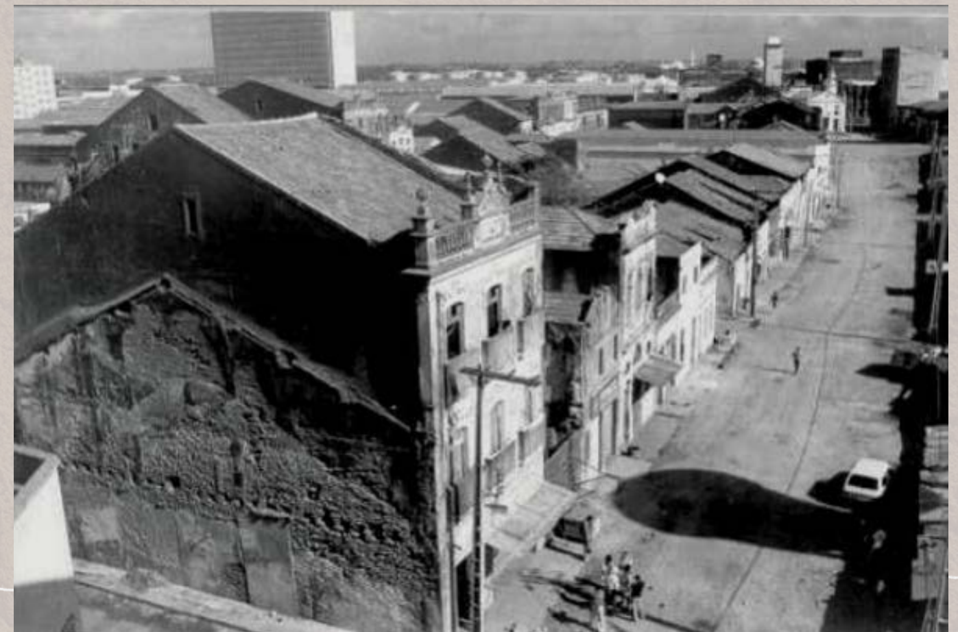
Figura 4 - Rua do Pilar no século XX, antes de ser demolida.
