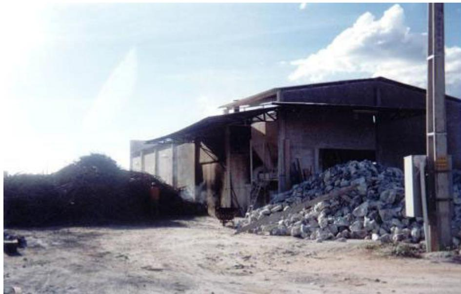
Figura 2.9 - Empresa calcinadora utilizando forno tipo “Barriga Quente” com combustível lenha.
