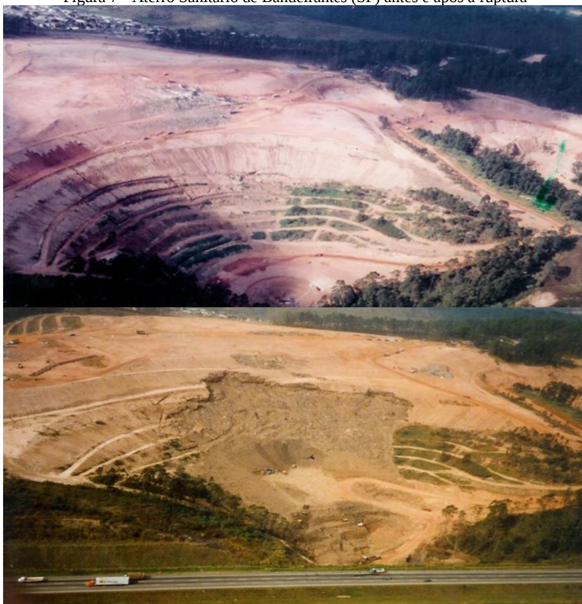
Figura 7 - Aterro Sanitário de Bandeirantes (SP) antes e após a ruptura
