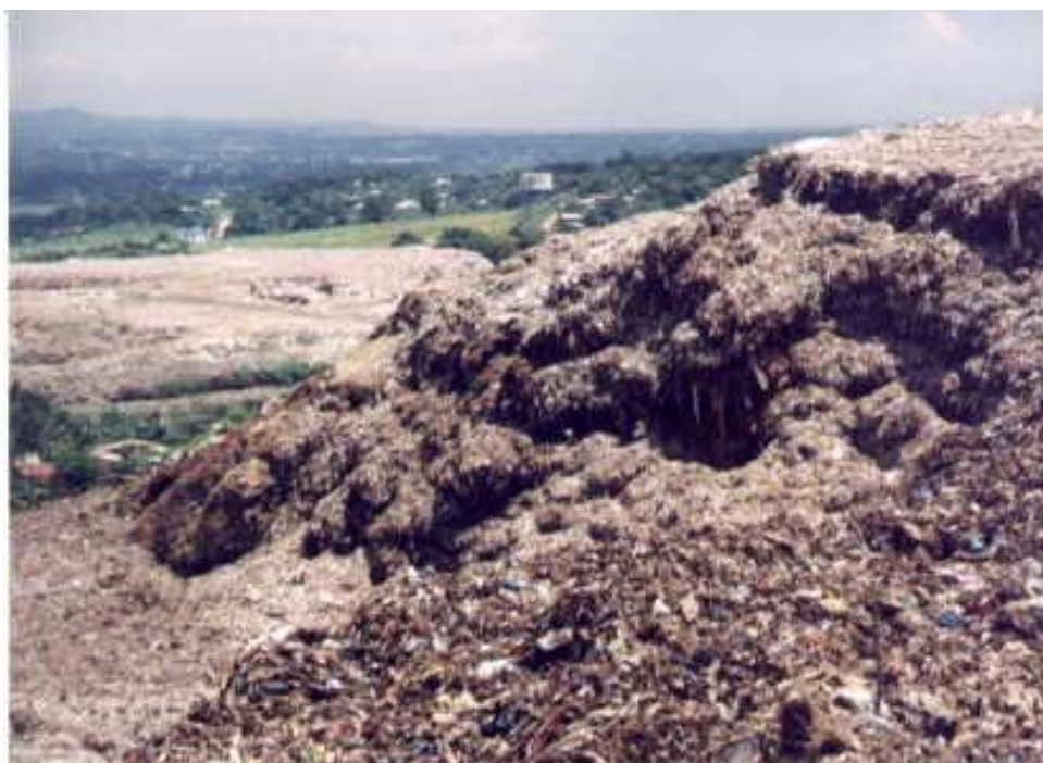
Figura 9 - Ruptura ocorrida em Payatas (Filipinas) em 2000.
