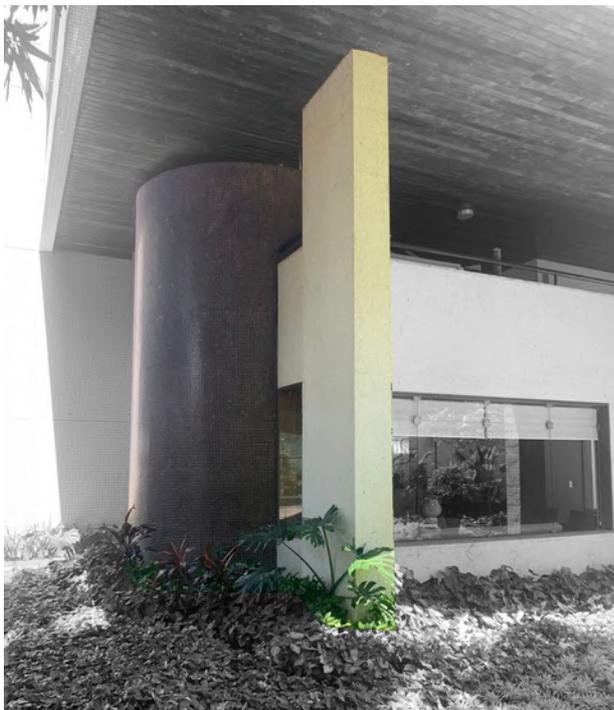
**27.** Fotografia da circulação vertical curva que leva ao mezanino. Observa-se detalhe da fresta, ela não encosta no forro em madeira
