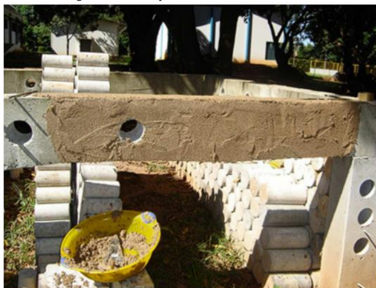
Figura 12 – Gel aplicado em estrutura de tamanho real
