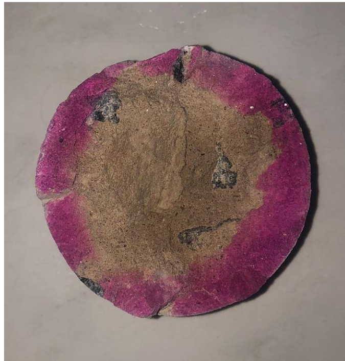
Figura 27 - Final do tratamento de realcalinização método de manta.
