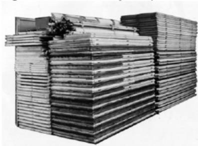
**Figura 46** - Peças pré-fabricadas que compõem a packaged house (1942)
