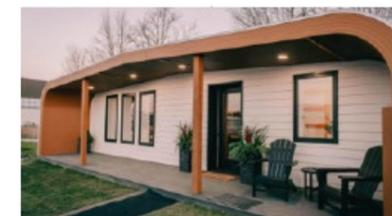
**Figura 52** - BioHome 3D foi produzida pela Universidade de Maine, com um bioplástico totalmente reciclável, composto com 20% de bambu e o restante de PLA (ácido polilático) e bioplástico. O tempo de impressão não foi divulgado, mas pretendem desenvolver a tecnologia para que possam imprimir uma casa, que tem 61,30m<sup>2</sup>, a cada dois dias.
