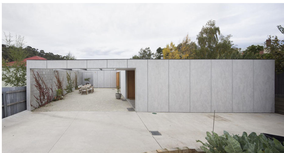
Figura 73: Fachada com placa cimentícia
