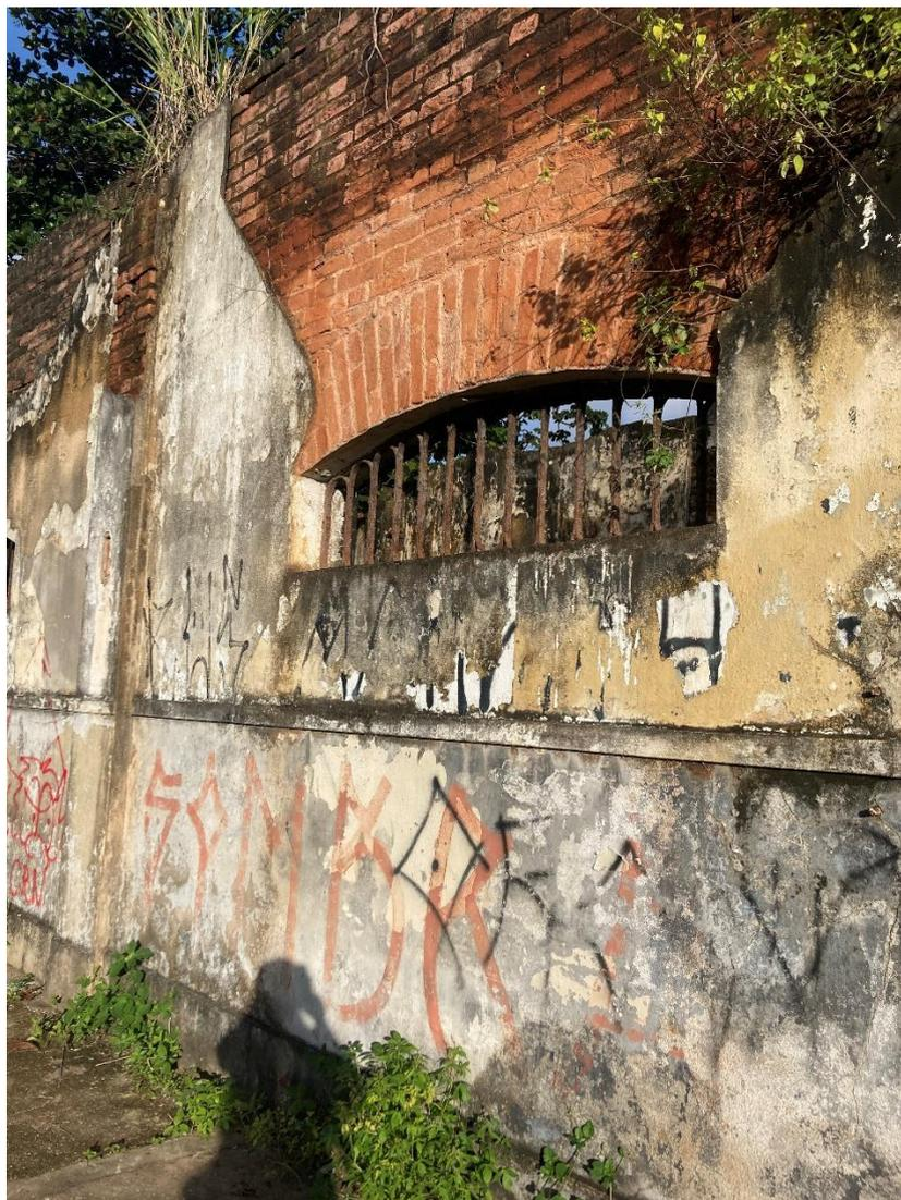
Figura 26. Fachada da Estação com alvenaria exposta. (Fonte: Autora, 2023)
