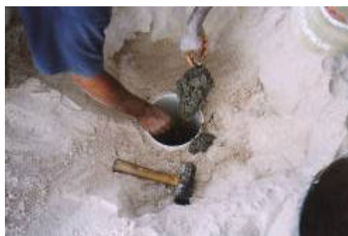
d) Concretagem do tubo de PVC.
