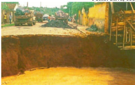
Figura 2.10: Colapso em Sete Lagoas, em Minas Gerais, no ano de 1988.
