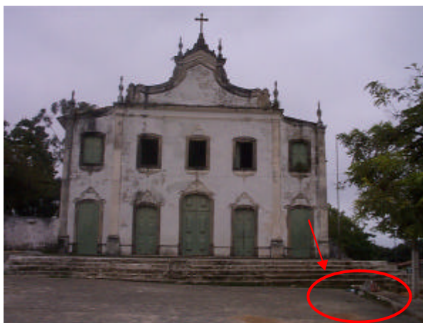
Figura 7.4: Marco localizado na rua Muribeca, em frente à Igreja Nossa Senhora do Rosário.
