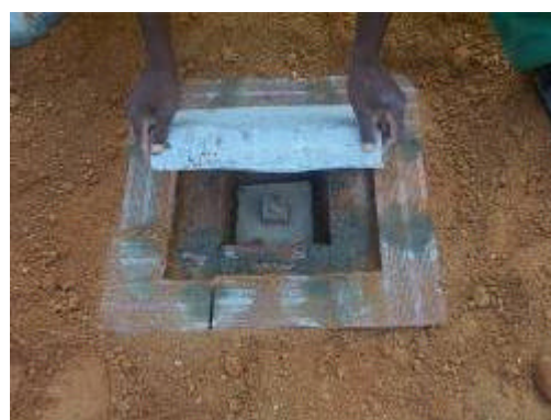
d) Colocação da placa protetora.
