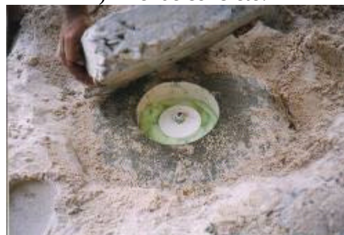
h) Colocação da placa protetora.
