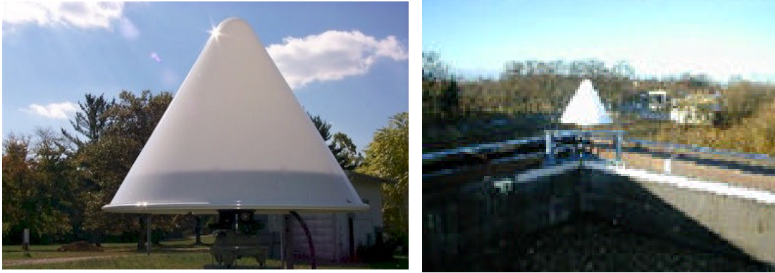
Figura 6.2: Foto da antena TRIMBLE modelo TRM33429.20+GP TCWD e da estação da rede SAPOS 0651 localizada em Harz ( http://www.lgn.de/produkte/sapos/sender/station/cl.htm - acessada em 18 de agosto de 2004).
