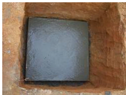
b) Execução do concreto.
