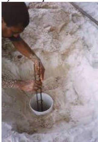
c) Implantação da armação.
