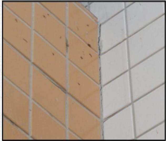
As fissuras e trincas resultam do **alívio de tensões** entre as partes de um elemento ou entre dois elementos que estejam em contato. As fissuras são aberturas mais estreitas e superficiais, na maioria das vezes causadas por **variações de temperatura ou retração do material**. As trincas são tidas como expressão coloquial e são fissuras mais largas e profundas.
