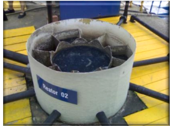
(b) Pontos de distribuição do afluente localizados no topo de cada reator.
