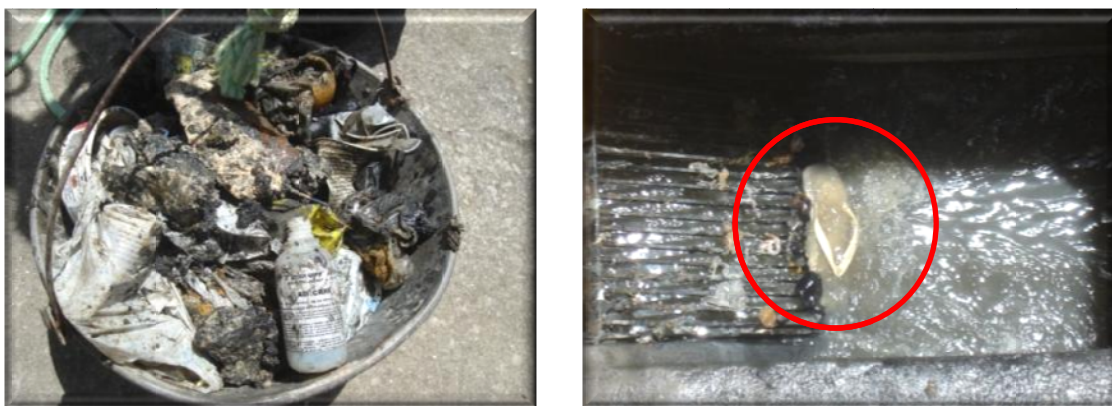
Figura 5.1: Principais resíduos encontrados nas grades de barras.
