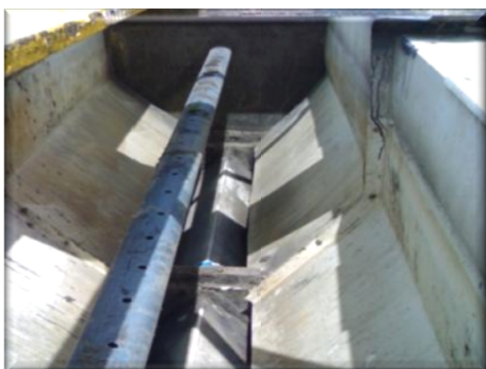
(a) Tubos perfurados após limpeza
