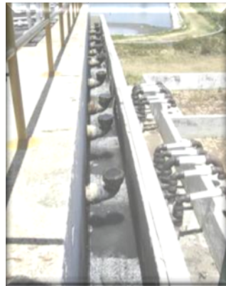
(b) Calha lateral de junção dos efluentes dos reatores UASB.
