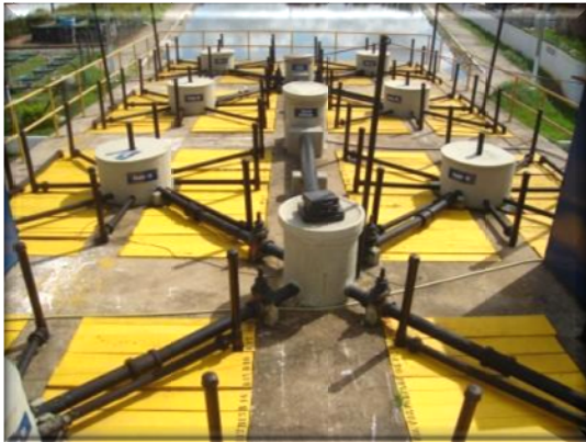
(a) Vista geral dos reatores UASB e sistema de distribuição do afluente.
