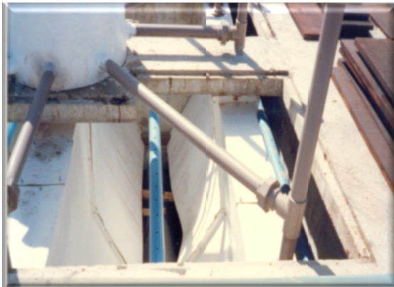
(a) Sistema tubos perfurados para coleta do efluente do reator UASB.
