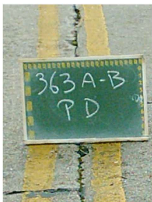
(d) falha na selagem de juntas
