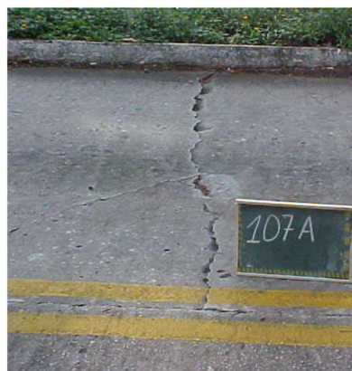
(e) fissuras transversais.
