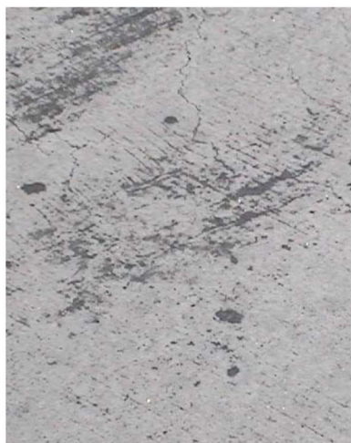
(g) fissuras de retração plástica.
