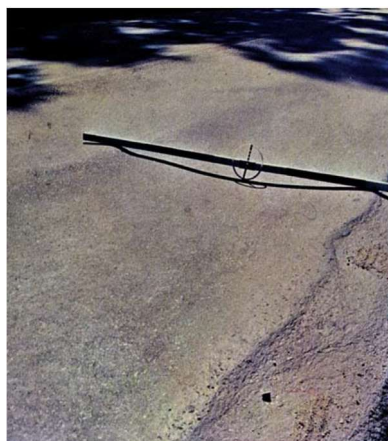
(a) afundamento plástico de trilha de roda.
