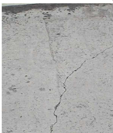
(a) fissuras diagonais.
