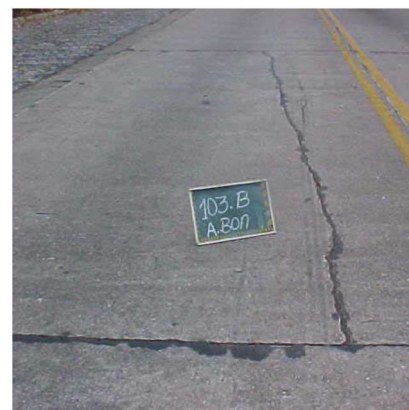
(f) fissuras longitudinais.
