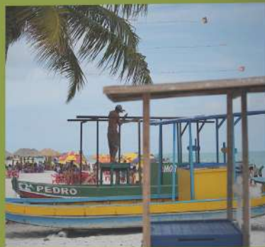
Reparação e pintura de barcos. Praia da Vila Eduarda, fevereiro de 2009.
