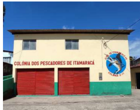
4: Prédio da Colônia de Pescadores Z11.
