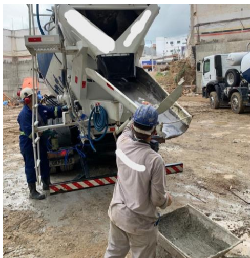
Figura 5 – Coleta da amostra no início da descarga do concreto
