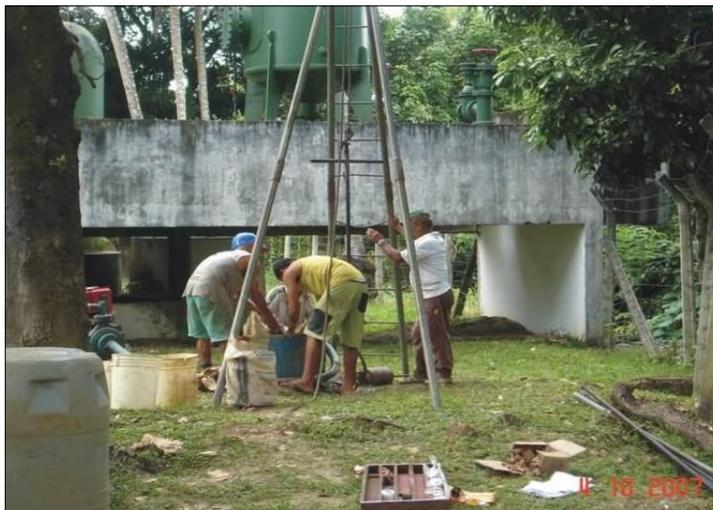
Figura 4.18 – Foto dos furos de Sondagem, método de percussão, ensaio SPT (Paiva, 2009).
