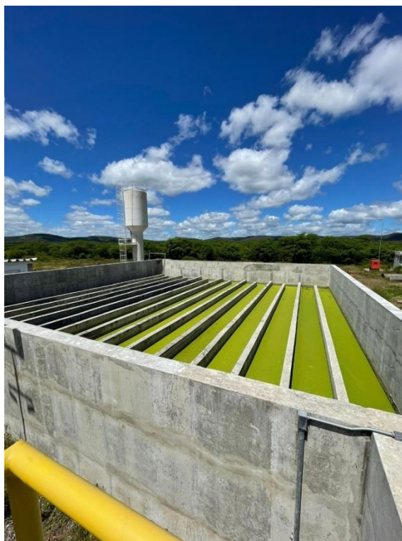
Figura 15 – Tanque de contato Santa Cruz.
