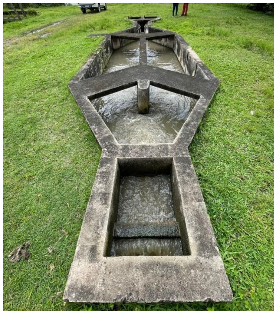
Figura 7 – Caixa de areia e calha Parshall de Sirinhaém
