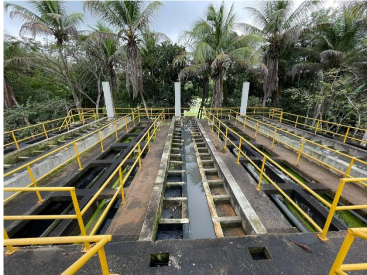
Figura 2 – Reator UASB de Rio Formoso.
