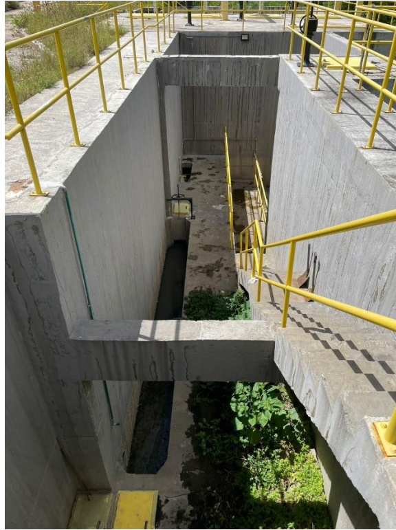
Figura 11 – Caixa de areia e calha Parshall de Santa Cruz.
