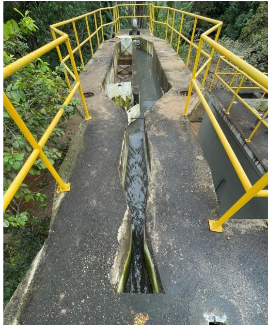
Figura 1 – Calha Parshall de Rio Formoso.
