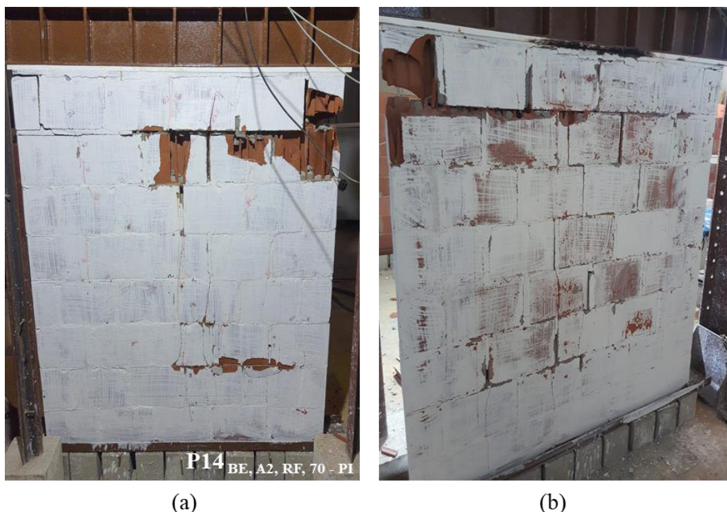
Foto 32 – Modo de falha da parede P14: (a) vista frontal e (b) vista posterior
