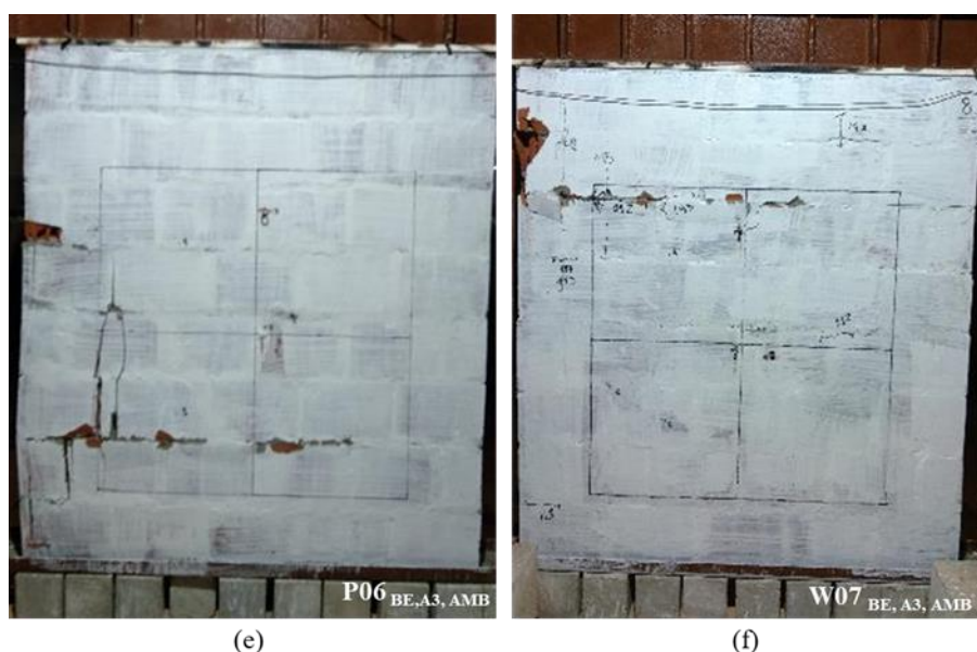
Foto 24 (cont.) – Modo de falha das paredes estruturais
