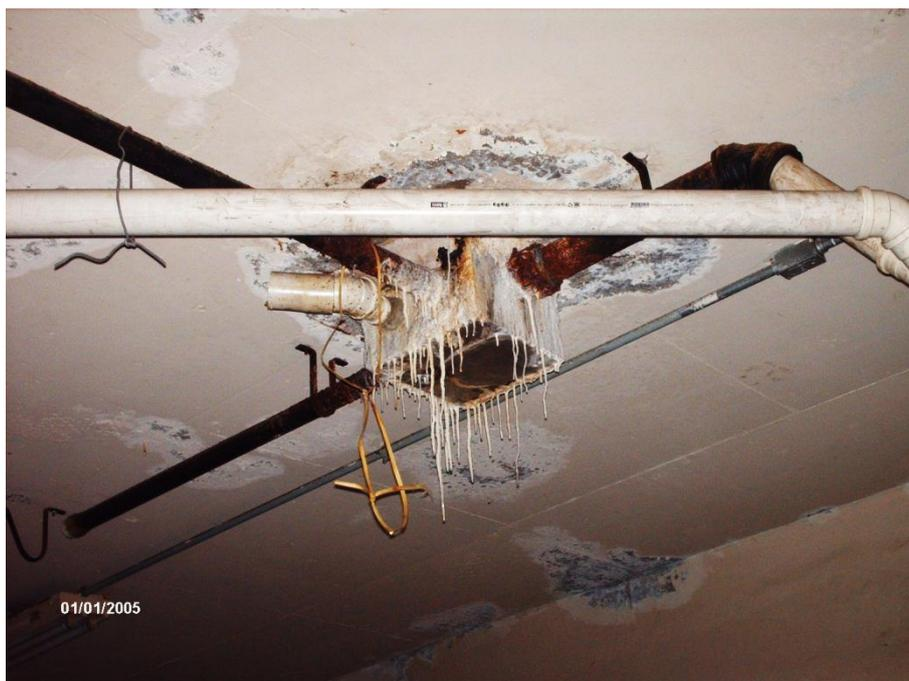
Figura 2.15. A eflorescência ocorre devido a lixiviação do hidróxido de cálcio
