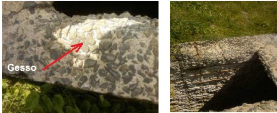
Figura 2.5a e b. Formação de gesso, em uma estrutura de concreto armado de uma estação de tratamento de esgoto da COMPEA no Arruda, PE, em 2009.
