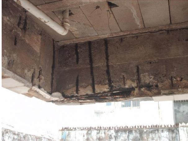
Figura 2.16. Pipocamento do concreto
