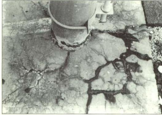
Figura 2.9. Fissuração na base de concreto armado, de uma torre de rede elétrica, Thomaz (2008)
