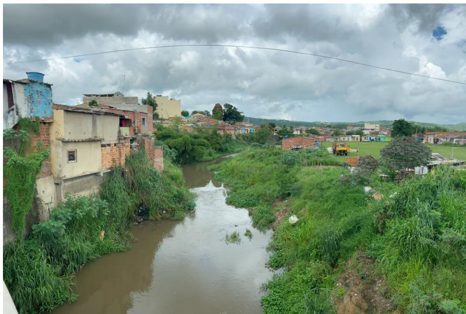
Figura 04: Trecho do rio Tapacurá evidenciando residências construídas muito próximas ao rio no município de Vitória de Santo Antão
