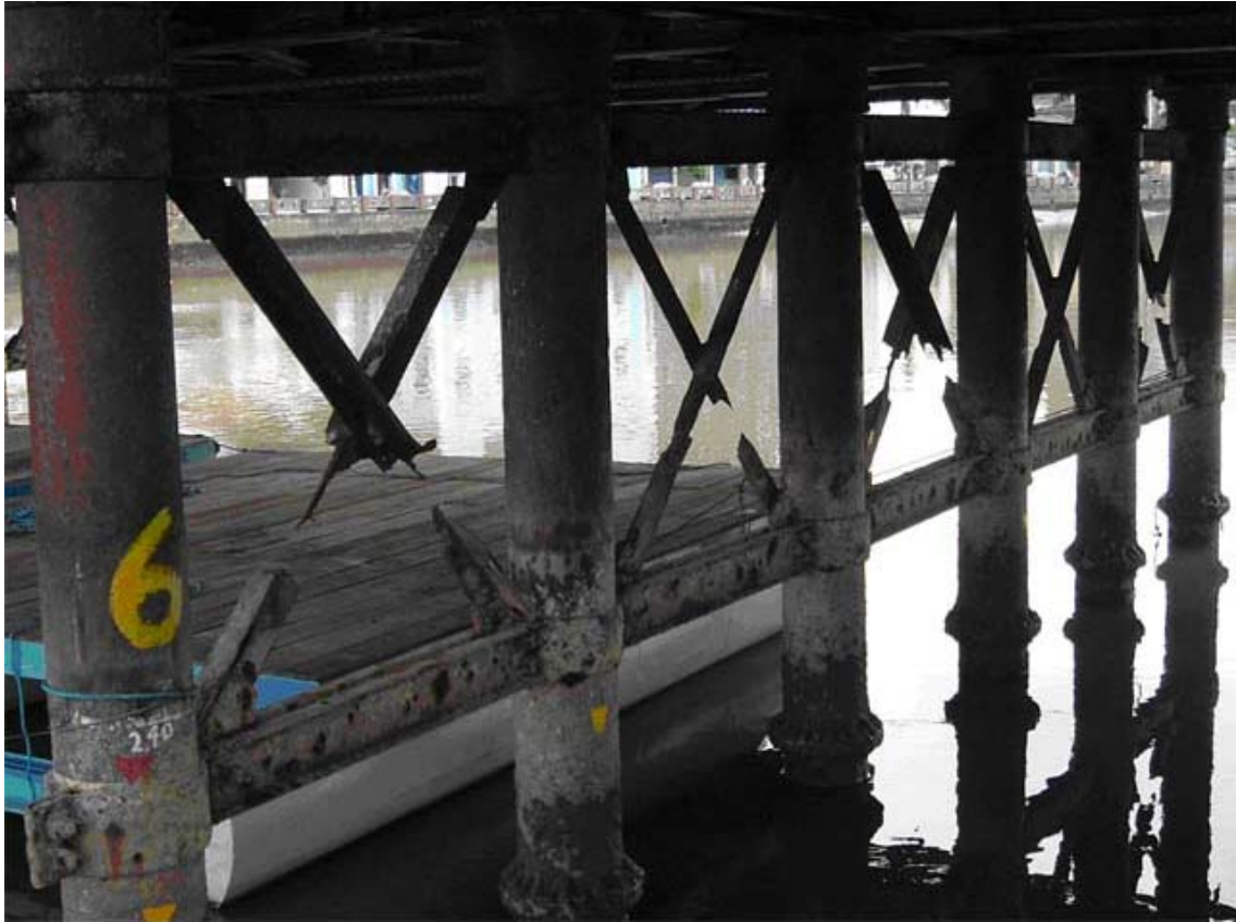
Figura 3.6 – Contraventamentos rompidos.
