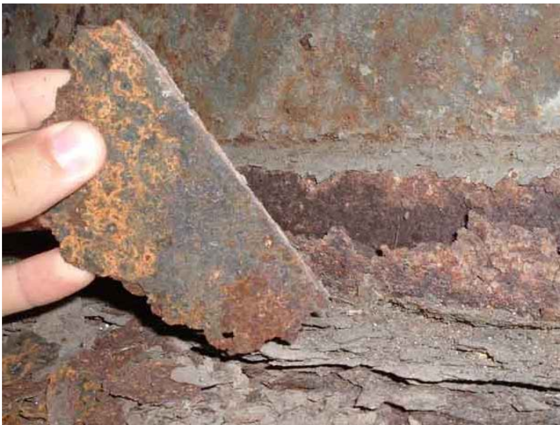
Figura 3.5 – Detalhe do estado de oxidação das vigas de bordo do balanço dos passeios.
