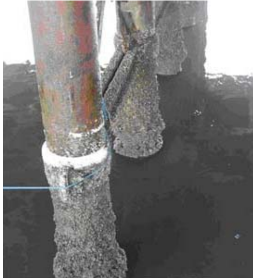
Figura 3.7 – Oxidação, encrustamento e redução da seção dos pilares.
