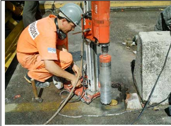
Figura 3.15 – Perfuração do tabuleiro da ponte através de sondagem rotativa, para a execução das estacas do bloco BL 9.
