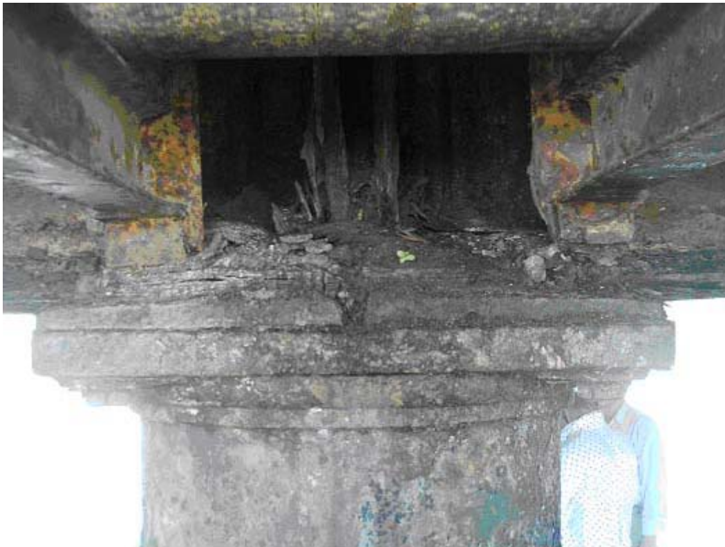
Figura 3.8 – Placas de chumbo comprometidas.
