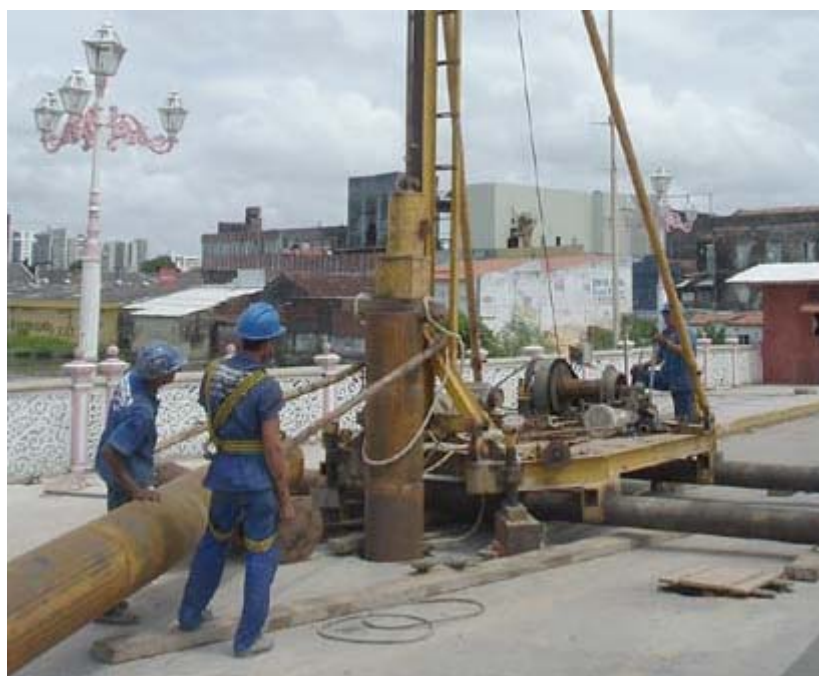
Figura 3.10 – Cravação das camisas metálicas (ou camisas perdidas).
