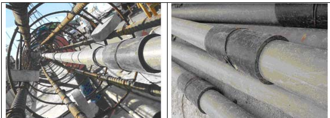
Figura 3.12 – Posicionamento do tubo manchete no centro da armação.
