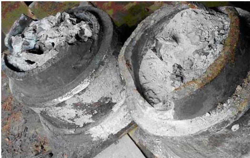
Figura 3.2 – Detalhe do material de preenchimento das estacas originais da ponte.
