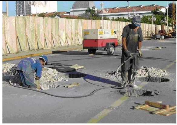
Figura 3.16 – Perfuração do tabuleiro da ponte através de britadeiras, para a execução das estacas dos demais blocos.
