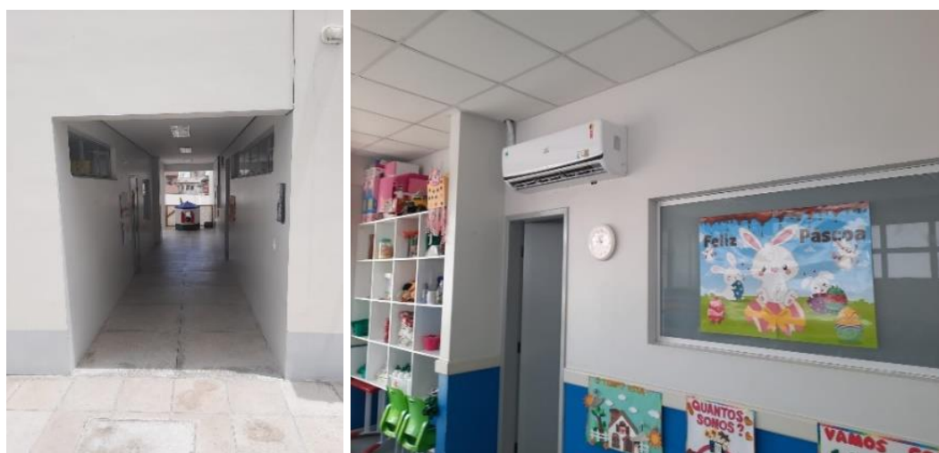
Figura 23: Salas de aulas expostas ao calor.
