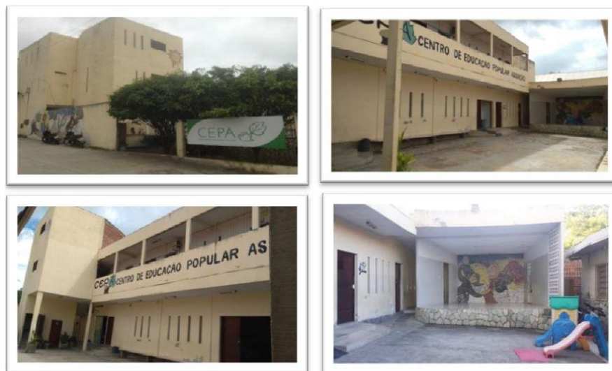
Figura 1: Fotos da estrutura física da entidade. Fonte: Arquivo do CEPA (2017)
