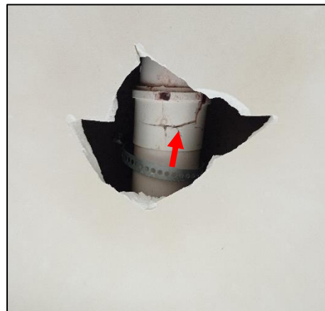
Figura 6 - Conexão sanitária danificada
