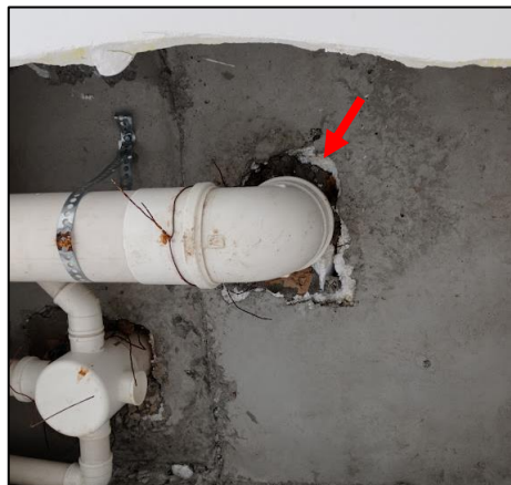
Figura 5 - Má ancoragem do tubo de esgoto na laje
