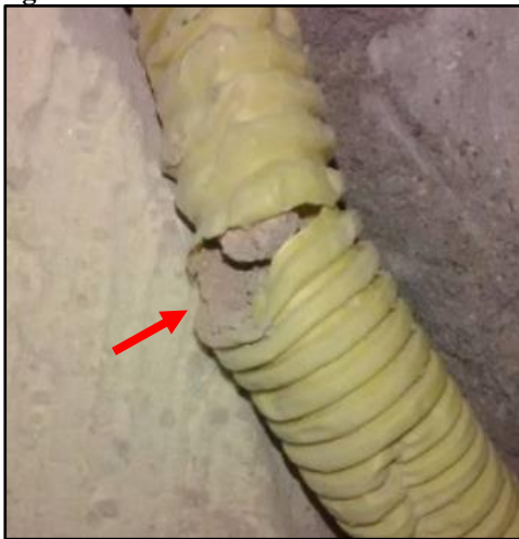
Figura 8 - Eletroduto obstruído com concreto
