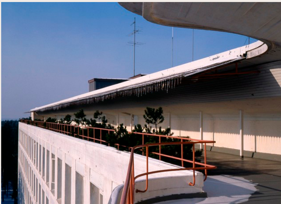
Figura 19: O terraço solar superior e sua marquise curva. Foto: Soile Tirilä. Fonte: HEIKINHEIMO, M. Paimio Sanatorium . Helsinki 04 jul. 2018.
