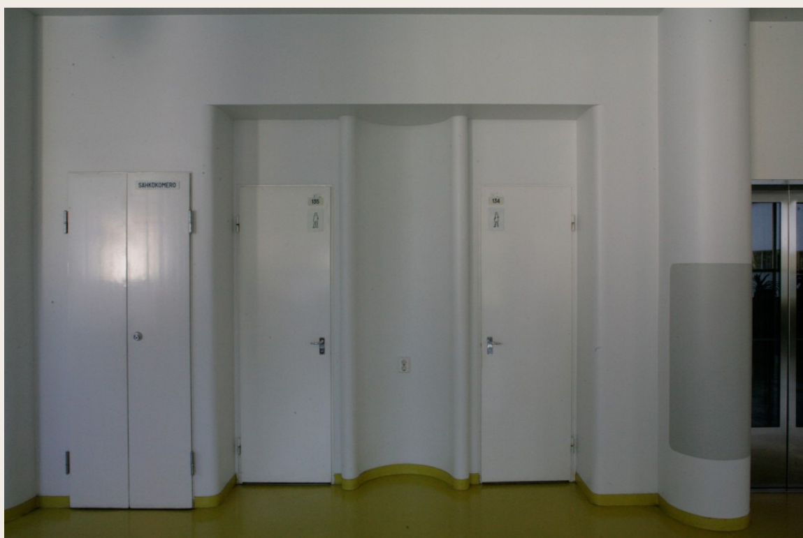
Figura 22: As paredes do lobby possuem formas arredondadas. O objetivo era diminuir a quantidade de quinas ao máximo possível para facilitar a limpeza e evitar o acúmulo de poeira. Foto: Sami Heikinheimo © arkbyroo.
