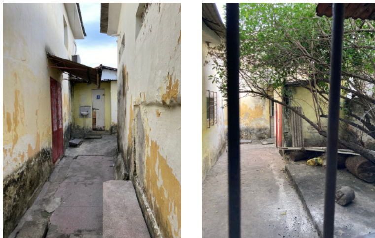
Figura 59 e 60: Vista do corredor e do pátio posterior
