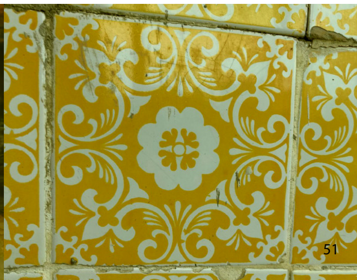
Figura 89: Azulejo amarelo da fachada principal Fonte: Autoral.
