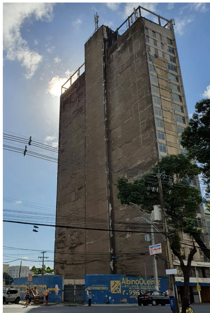
Figura 13 - Edifício Garagem Piratininga Fonte: Diego Lopes, 2022
