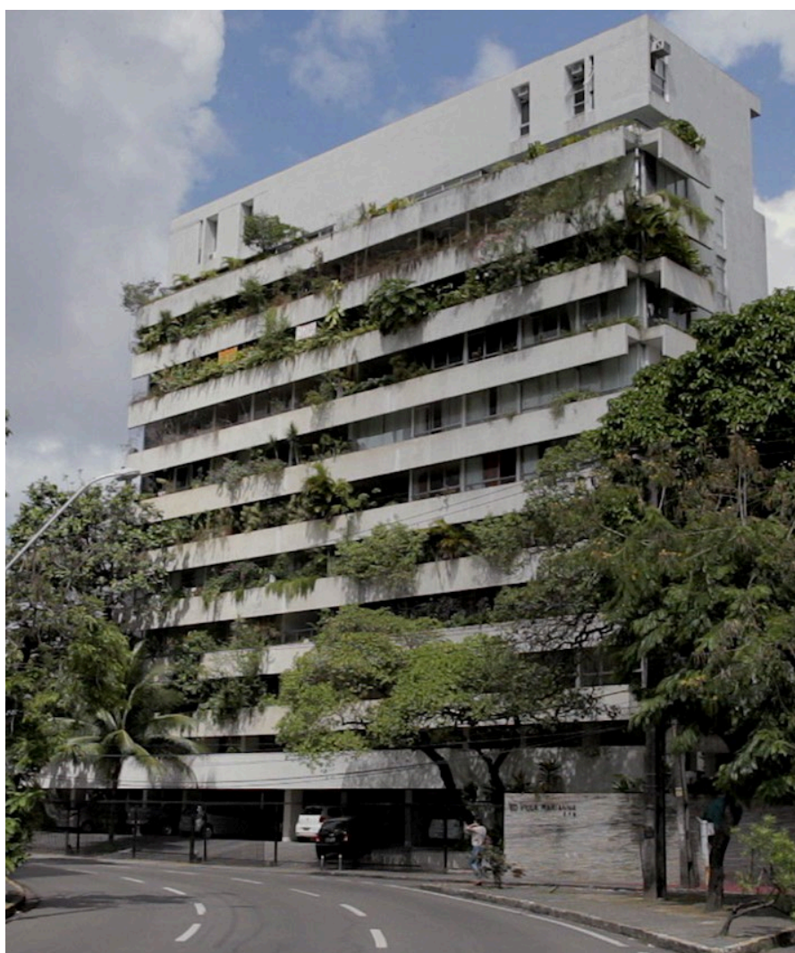
Figura 37 - Edifício Villa Mariana, 1976 Fonte: Bruno Firmino
