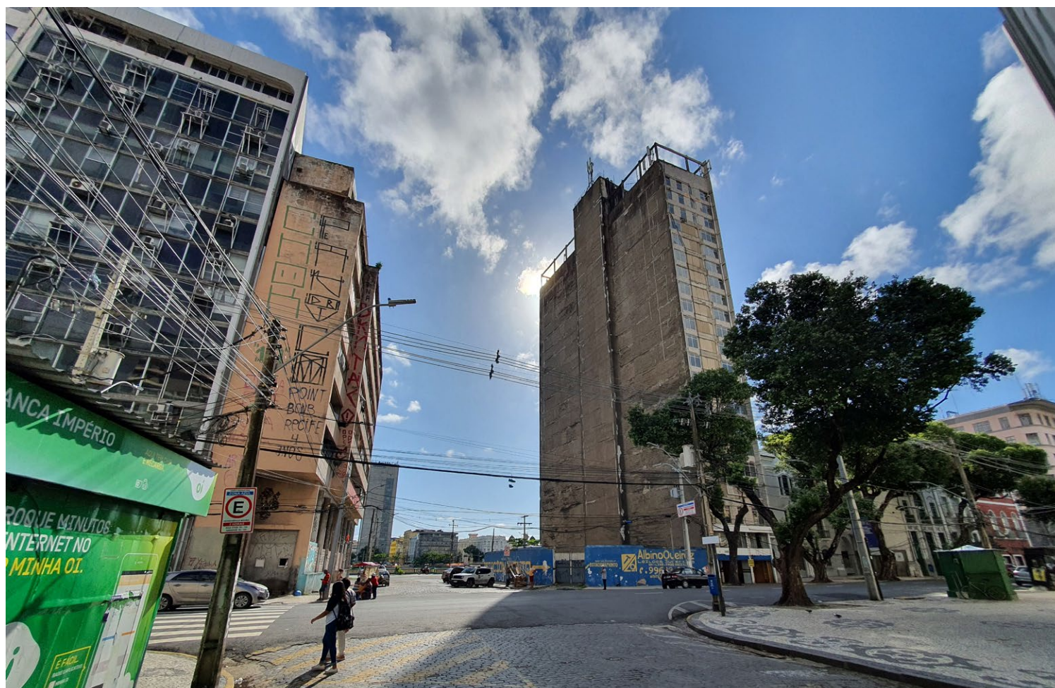
Figura 18 - Edifício garagem Piratininga Fonte: Diego Lopes, 2022
