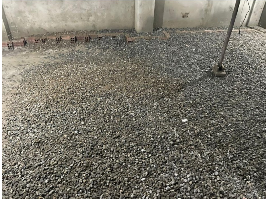
Figura 16 – Execução de colchão drenante com brita no subsolo da obra comercial
