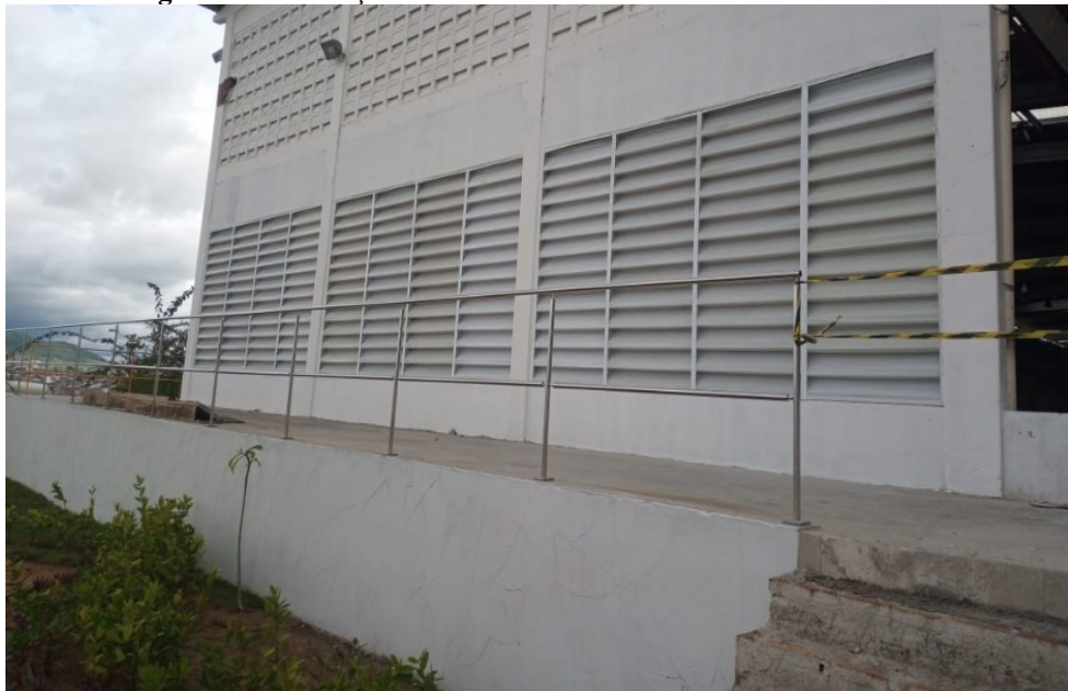
Figura 24 – Execução de venezianas industriais da obra industrial
