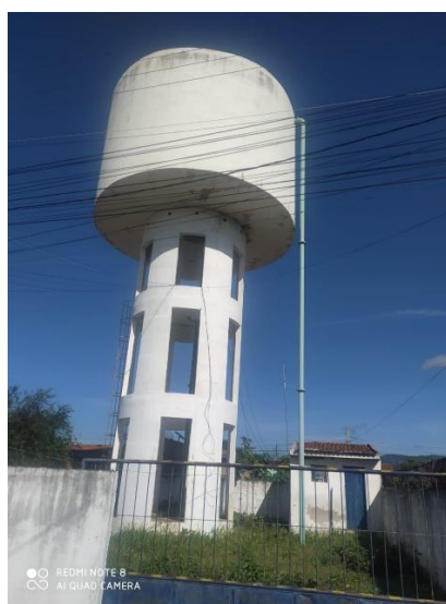
Figura 23 Reservatório da cidade de Flores - PE.
