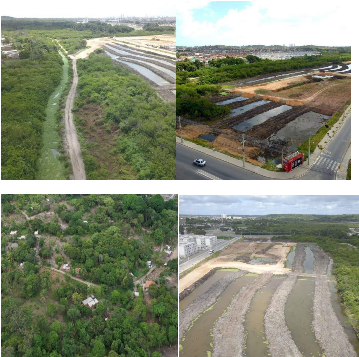
Figura 7 (4) – Imagens da degradação na Floresta Urbana da Jaguarana feita com uso de drone
