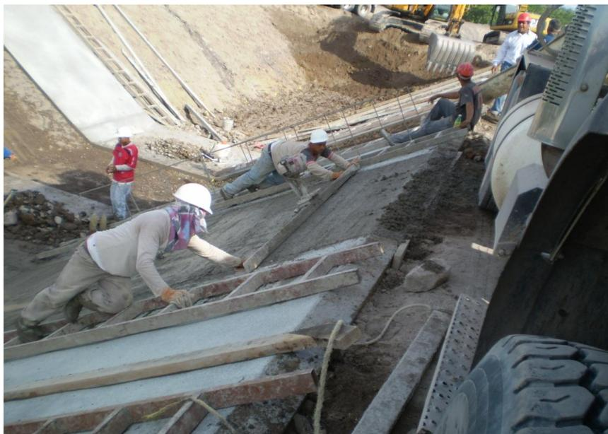
**Figura 29 - Execução do Revestimento**
