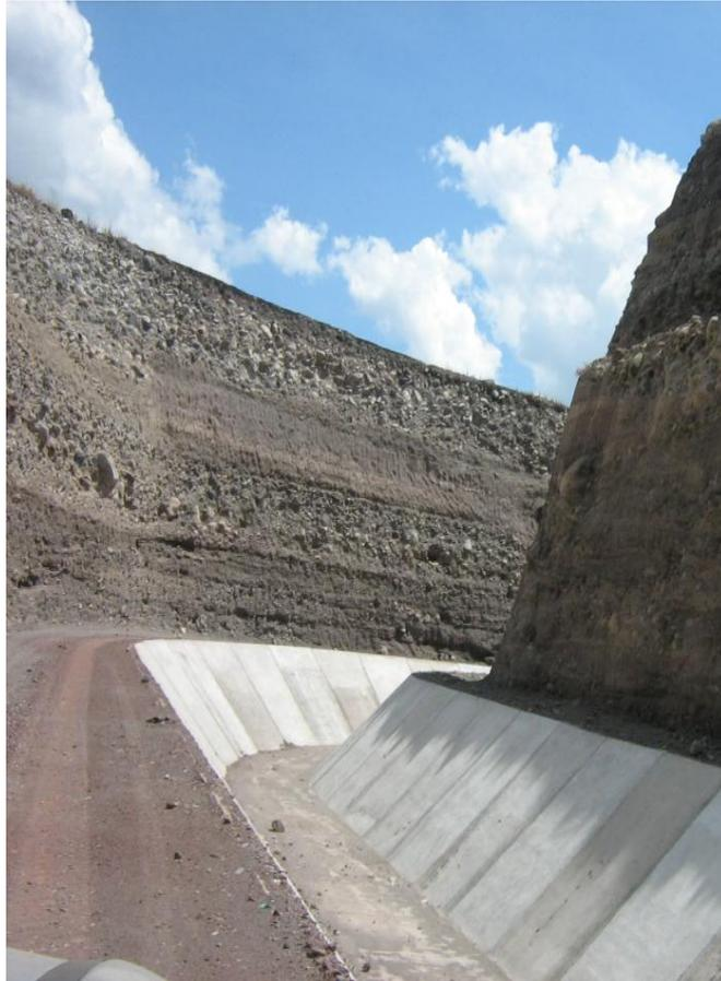
**Figura 27 - Trecho Inicial - Corte em Rocha e Conglomerado**
