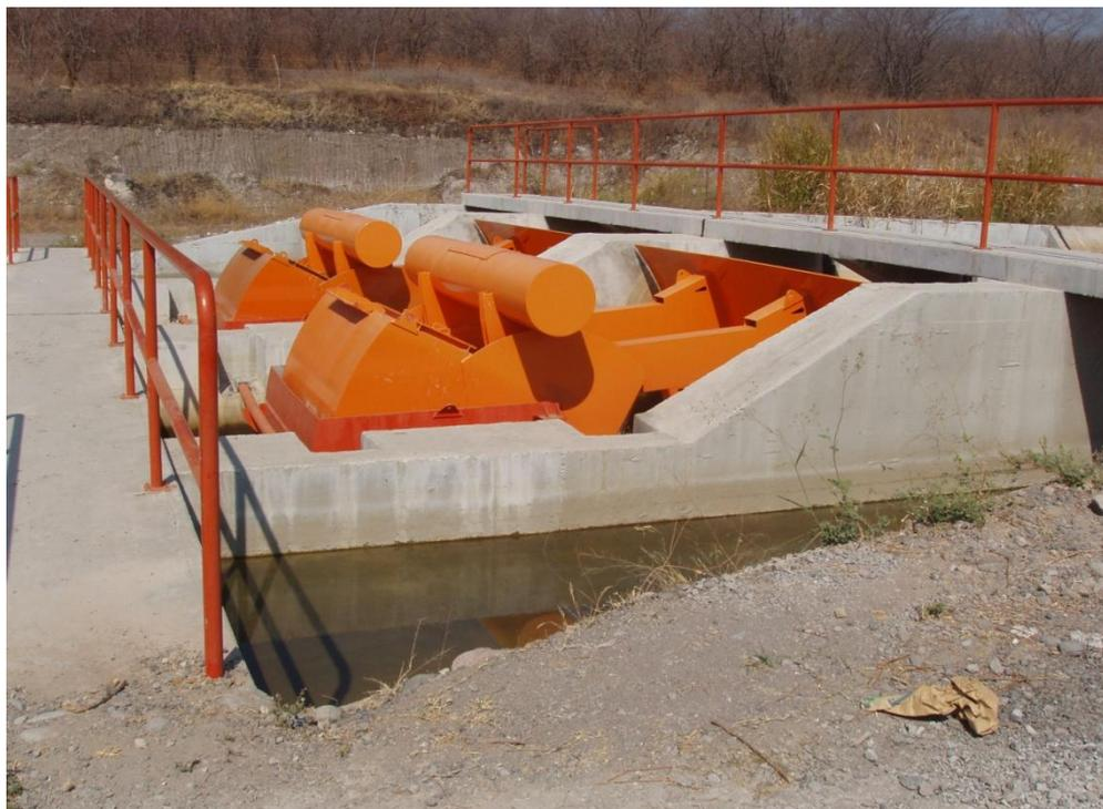
**Figura 24 - Comporta Hidromecânica para Controle de Nível - Nível**
