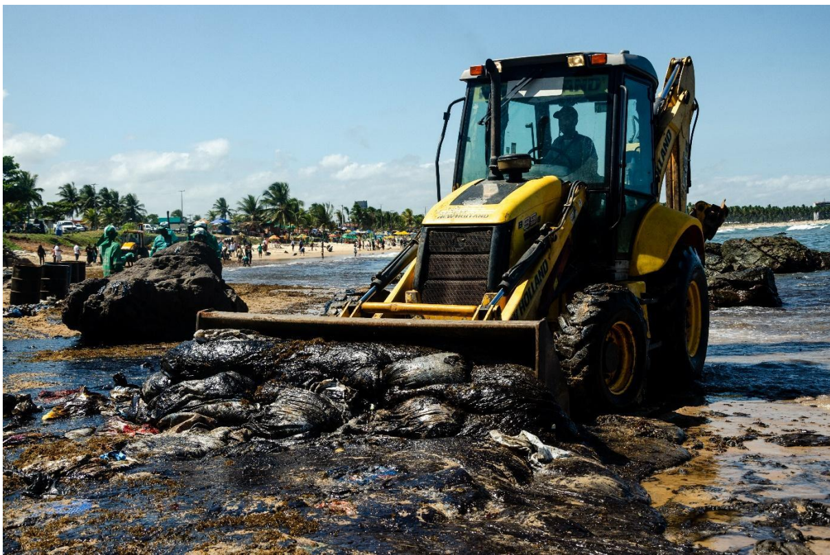
Figura 1 - Registro da poluição causada pelo derramamento de óleo na área de estudo.
