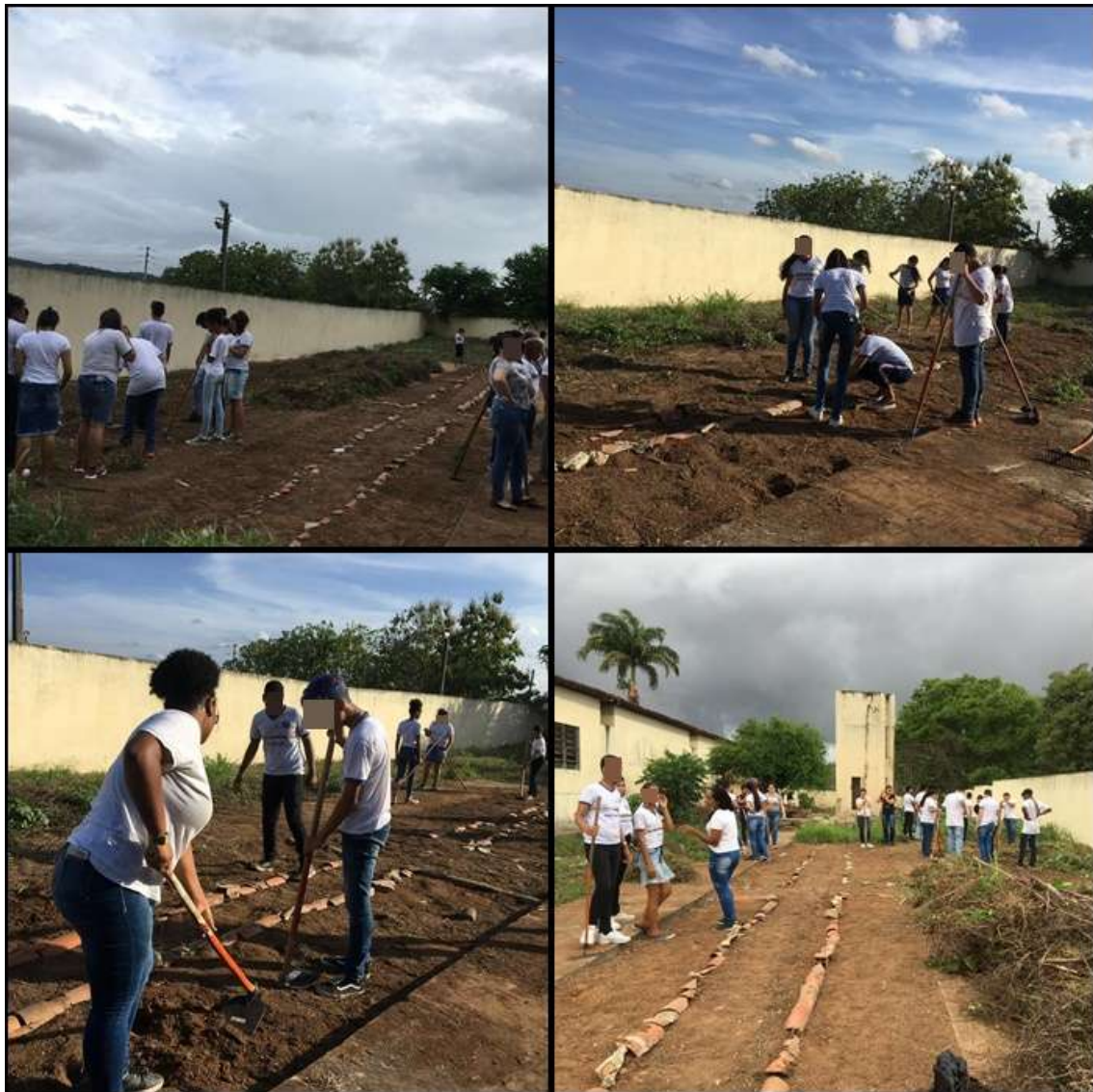
Figura 9 - Estudantes construindo os canteiros, utilizando enxadadas e ancinhos para remexer a terra. Fragmentos de telhas e tijolos foram utilizados para delimitar a área das leiras.
