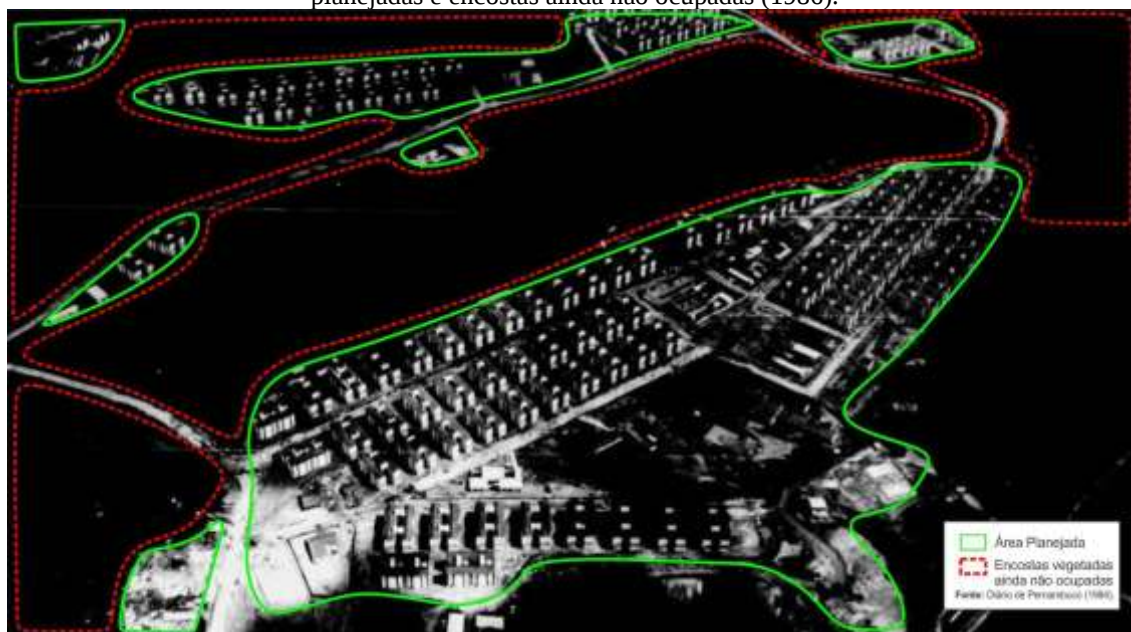
Figura 18: Imagem aérea do Conjunto Habitacional do Curado IV com delimitações das áreas planejadas e encostas ainda não ocupadas (1986).
