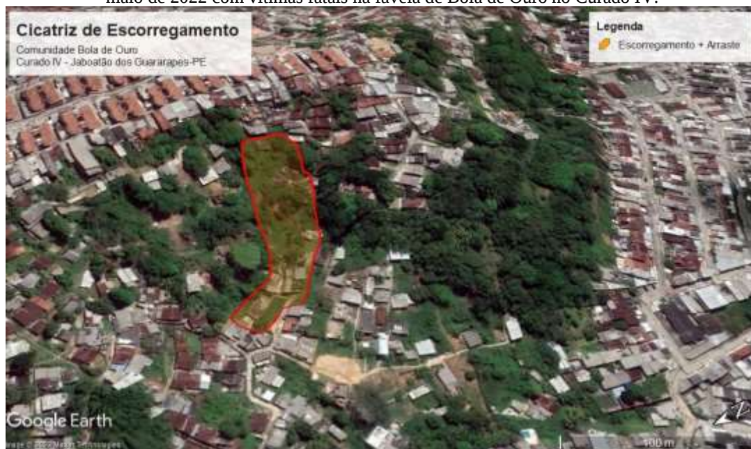
Figura 53: Polígono com demarcação da cicatriz deixada pelo escorregamento ocorrido no dia 28 de maio de 2022 com vítimas fatais na favela de Bola de Ouro no Curado IV.
