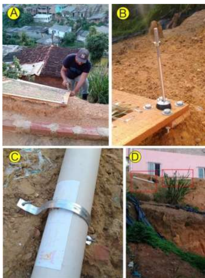
Figura 35: Instalação da medida protetiva e dos coletores de sedimento na encosta.
