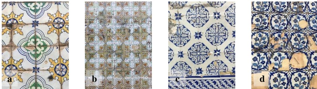
**a.** lascamento e danos ao vidrado; **b.** desbotamento do esmalte e lascamento; **c.** lascamento e manchas de umidade; **d.** lascamento, danos ao vidrado e biofilme.
