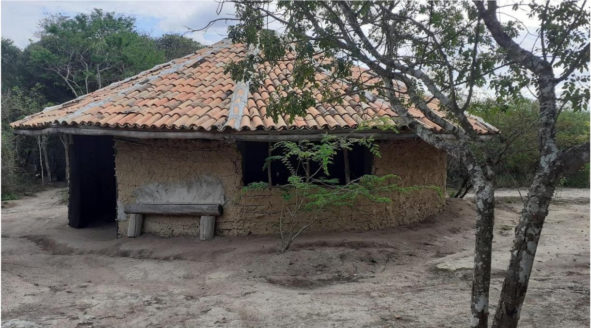
Observa-se o espaço circular construído a partir de material de taipa. Anteriormente era uma bioconstrução, mas o telhado de palha foi substituído por telhas
