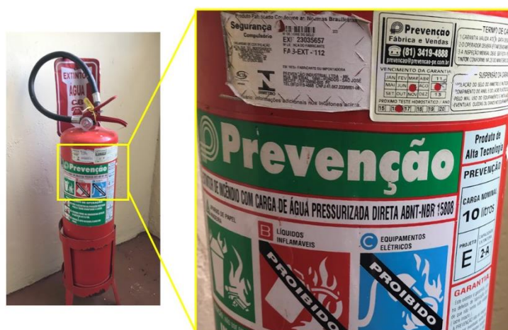
Figura 36 – Especificação e dados do dispositivo portátil instalado no Memorial de Gravatá
