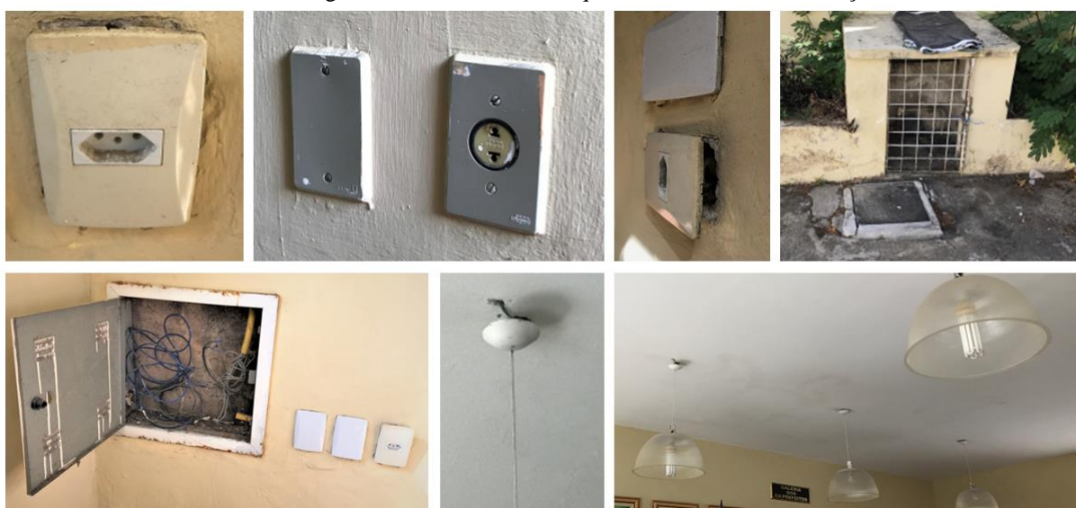
Figura 37 - Pontos elétricos que oferecem risco a edificação
