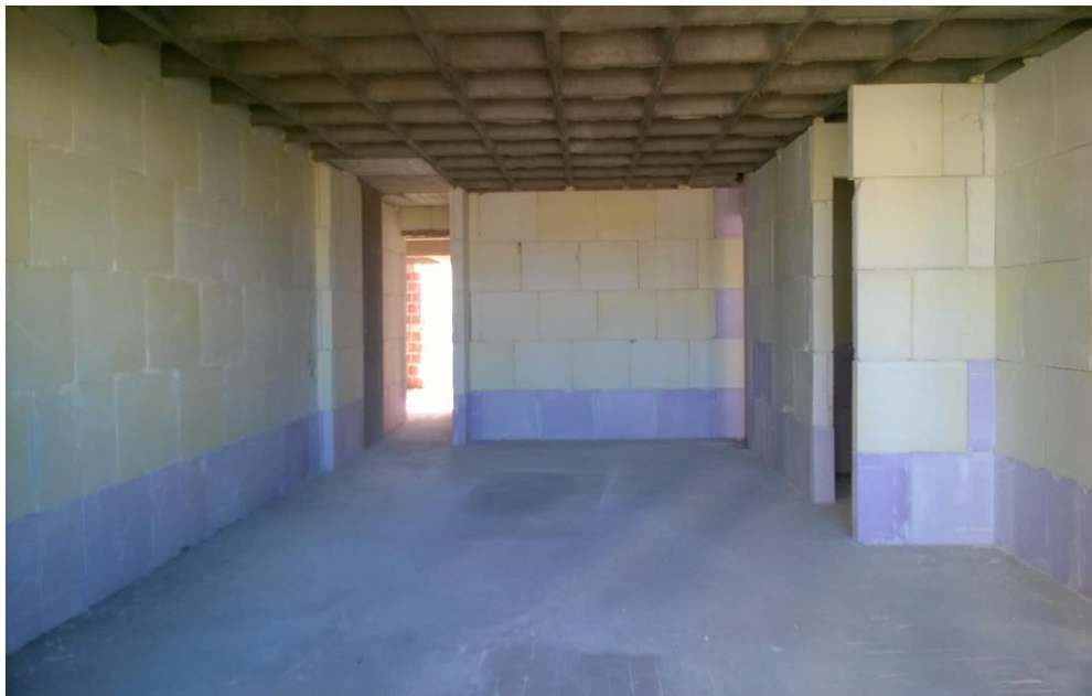
Figura 4 – Fotografia de vedações verticais compostas por blocos de gesso, gesso-cola e espuma expansiva de poliuretano
