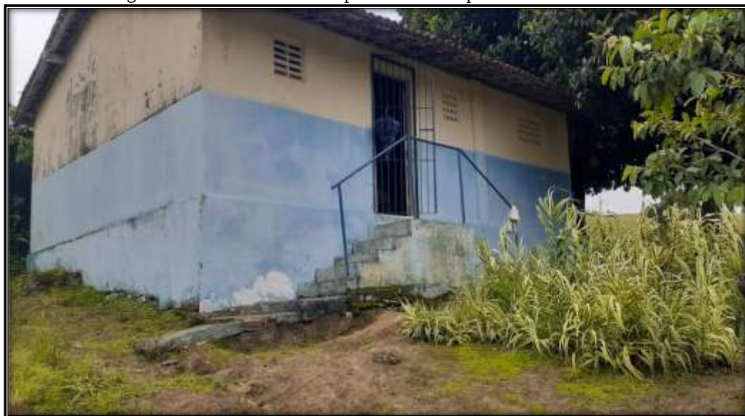
Fotografia 1 - Fachada da minha primeira escola/primeiro local de trabalho
